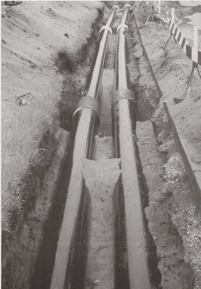
Układanie sieci ciepłej w technologii preizolacji. Fot. Archiwum
