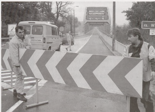
Remont mostu w Fordonie. Fot. Marek Chelminiak
