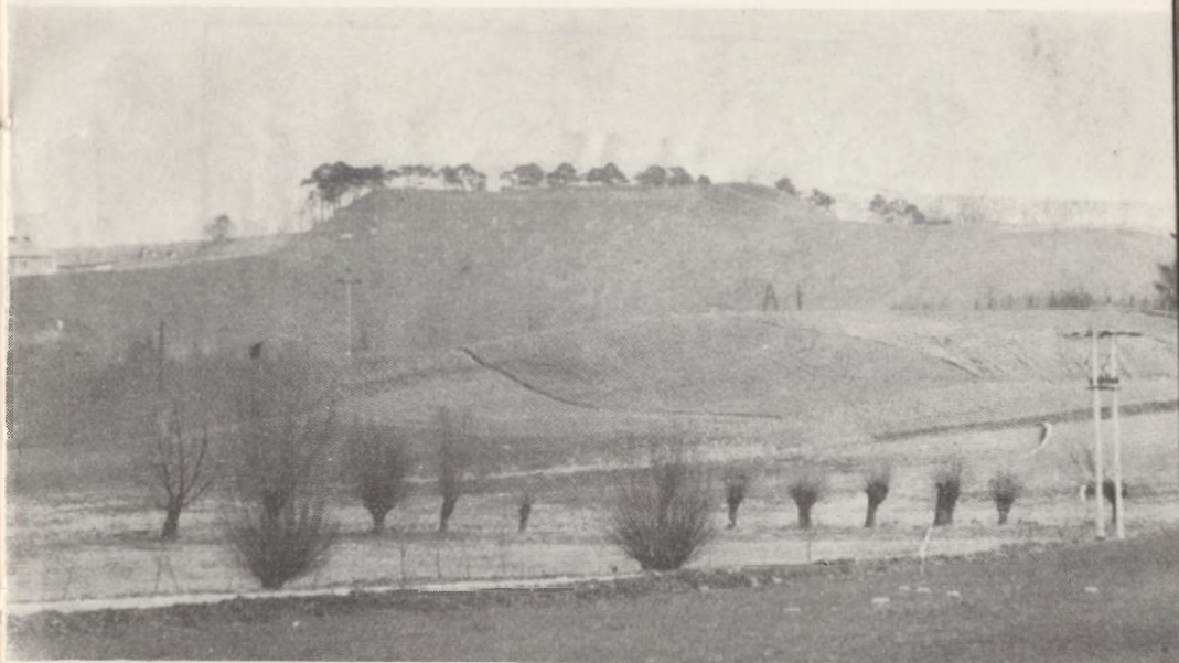
Zdj. nr 1. Świece n. Osą, pow. Grudziądz. Widok ogólny grodziska od strony zachodniej
