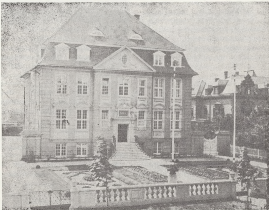
Budynek Muzeum i Biblioteki przy ul. Świerczewskiego 28
