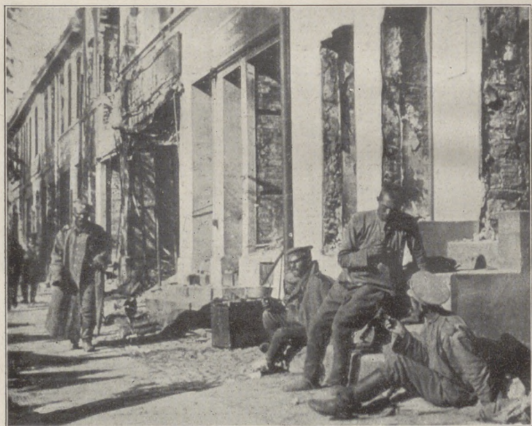
Russen bei den Aufräumungsarbeiten.
