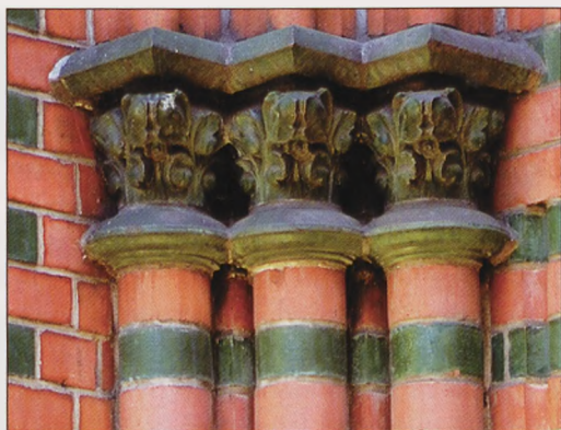
Ceramiczny detal w portalu głównym Dyrekcji Poczty fot. Łukasz Maklakiewicz
