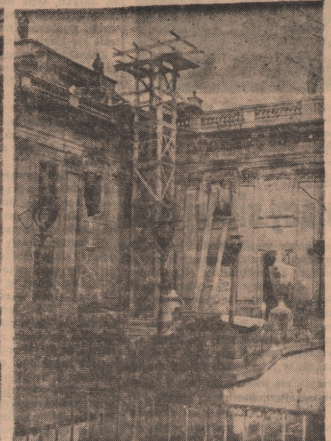
Po związaniu zarysowanych murów pałacu Łazien- kowskiego konstrukcją żelazo betonową zajęto się do- piero odbudową uszkodzonego i obrabowanego pałacu.
