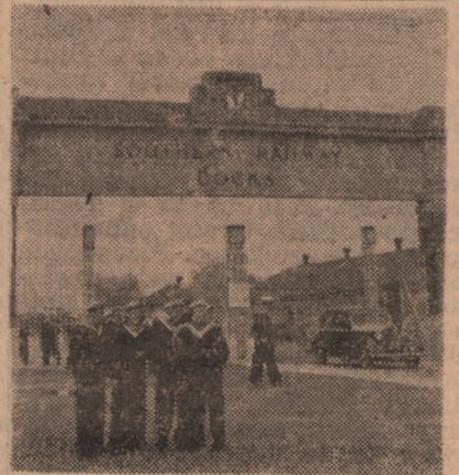
Southampton — Anglia. Wejście do wielkich warsztatów kolejowych.
