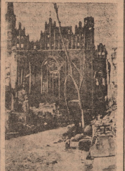
Katedra Morska od ul. Mariackiej, z której pozostały jedynie przedproża
