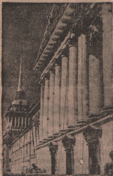
Straszliwe rany zadane bohaterstwu miastu przez niemieckich barbarzyńców zblizniają się. Zdjęcie przedstawia ostatnie prace przy odbudowaniu pięknego gmachu administracji
