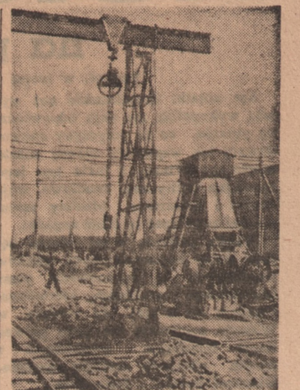
Budowa szybu na nowej kopalni węgla „Ziemowit“.
