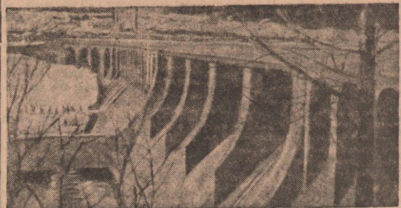
Tama na rzece Sole w Porąbce reguluje stan wody na tej rzece i chroni okolice przed niebezpieczeństwem powodzi w okresach odwilży.
