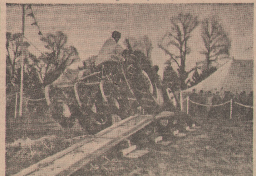
Wiele wynalazków wojennych oddaje dziś już usługi pracy pokojowej. Jednym z nich jest traktor, który dzięki swej oryginalnej budowie, polegającej na możliwości wysuwania w bok trzeciego koła, nie może ulec wywróceniu się nawet przy pochyleniu 25 stopni. Traktor taki, oddający szczególnie wielkie usługi na terenach górzyskich, zademonstrowała ostatnio amerykańska firma „Fordson Major”.
