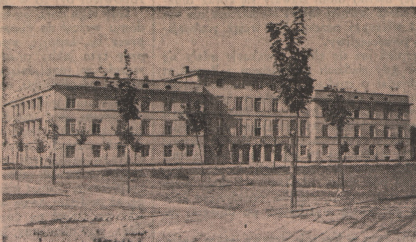
Sanatorium Zakładu Ubezpieczeń Społecznych w Inowrocławiu. (Patrz artykuł na str. 6)
