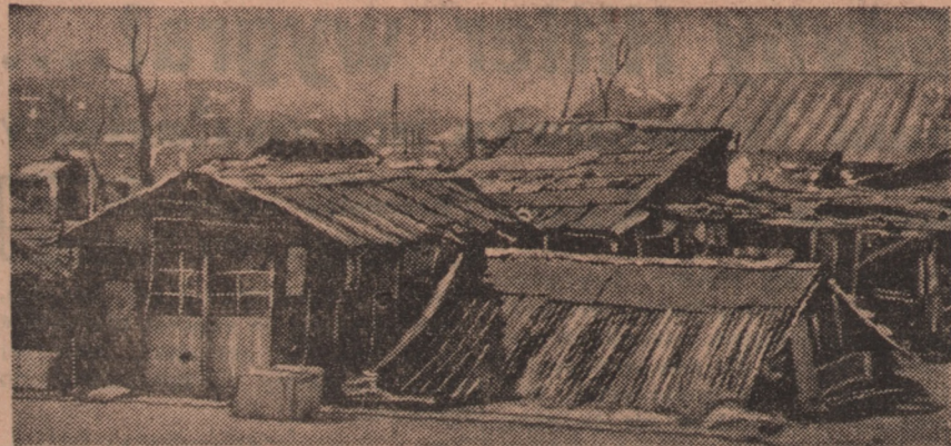
Tak wyglądają obecnie domy mieszkalne w zburzonej części stolicy Tokio. Japończycy postawili sobie własnoręcznie prowizoryczne domki ze znalezionych resztek zombardowanych budynków.
