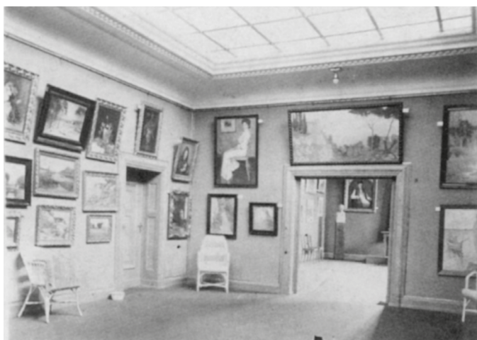
17. Sala malarska na I piętrze z widocznym świetlikiem (D. Schoenwald, M. Żebrowski, Ulice i zaułki Grudziądza : Wybickiego – Legionów, Grudziądz 2015)
