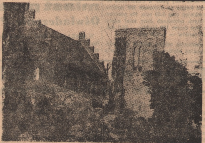
Odbudowa zabytkowej świątyni N. Marii Panny na Nowym Mieście w Warszawie posuwa się szybko naprzód. Na górnym zdjęciu widok kościoła w końcu lutego br. (Główna część odbudowana i pokryta dachem). Niżej: Rekonstrukcja zniszczonej prawie doszczętnie starożytnej wieży (wrzesień br.).
