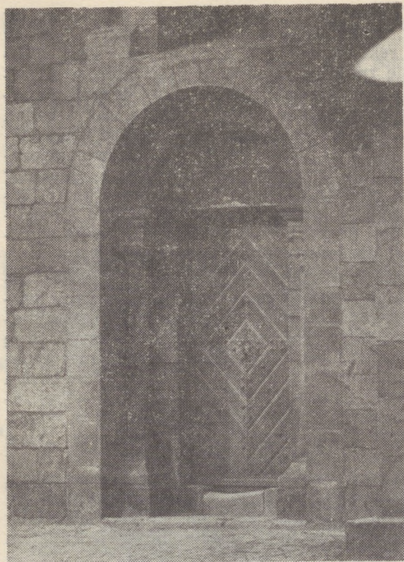
Jeden z portali kolegiaty w Kruszwicy na ścianie południowej
