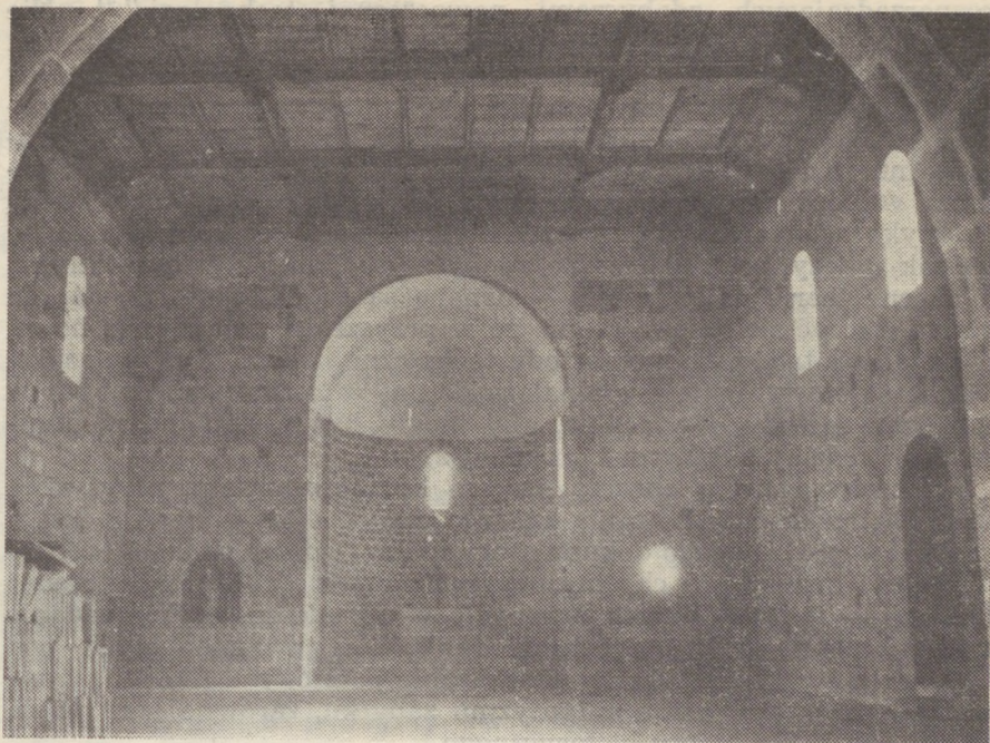
Wnętrze kościoła NM Panny w Inowrocławiu w czasie prac konserwatorskich — część wschodnia, apsyda
