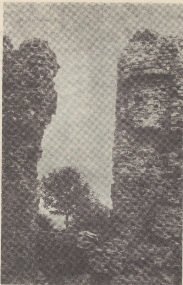
4. Raciążek, zamek. Zachodnia elewacja „kamienicy wielkiej”. Stan współczesny
