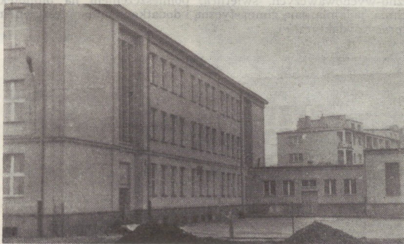
1. Gmach Szkoły Podstawowej nr 10 w czasie budowy boiska szkolnego
