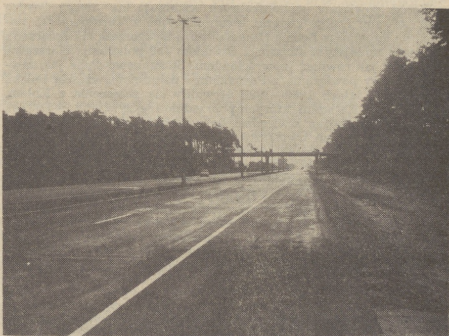
Fot. 1. Nowoczesna trasa wylotowa (E 16) w kierunku na Toruń. W głębi widoczne dwupoziomowe skrzyżowanie drogi wyjazdowej z Zakładów Azotowych II w budowie (1980).
