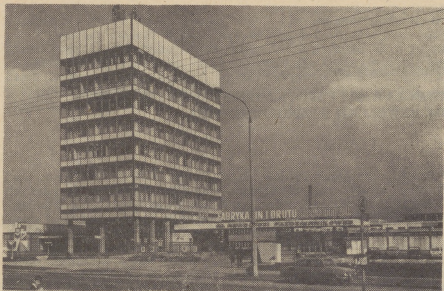
Biurowiec „Drumetu” — jeden z najciekawszych obiektów tego typu we wschodniej dzielnicy Włocławka (fot. Z. Czarnecki)
