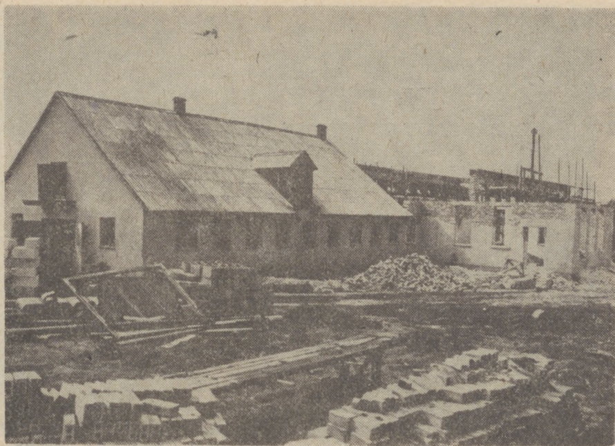
Zakład w Cetkach w czasie budowy
