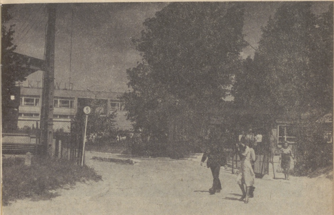
Wjazd do zakładu
