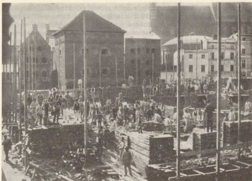
Prace murarskie przy budowie teatru w Toruniu
