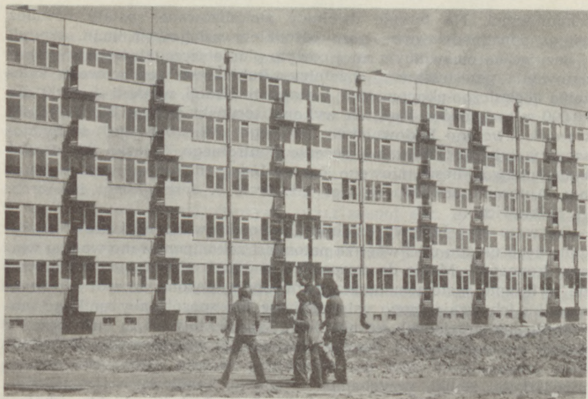
Elewacja bloku mieszkalnego na Rubinkowie
