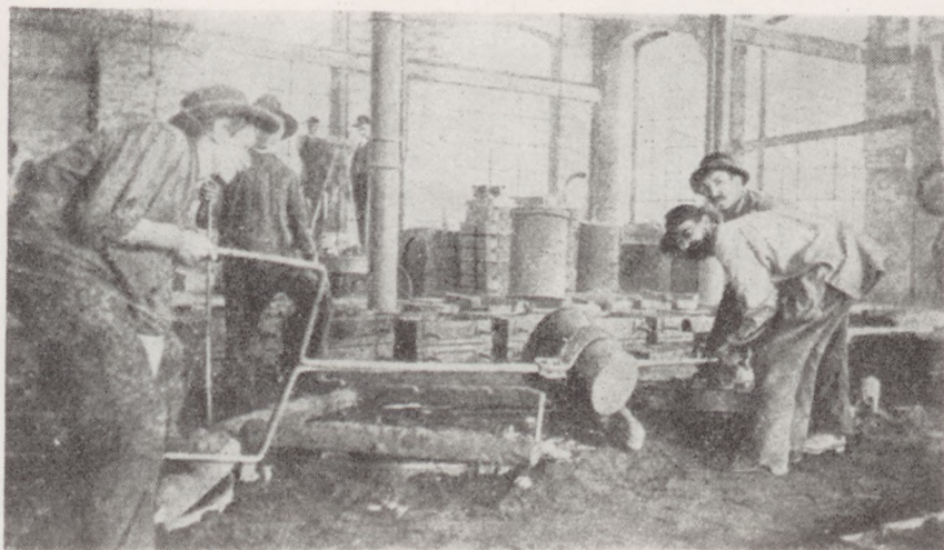
Północna część odlewni, robotnicy przy odlewie — stan z 1905 r.
