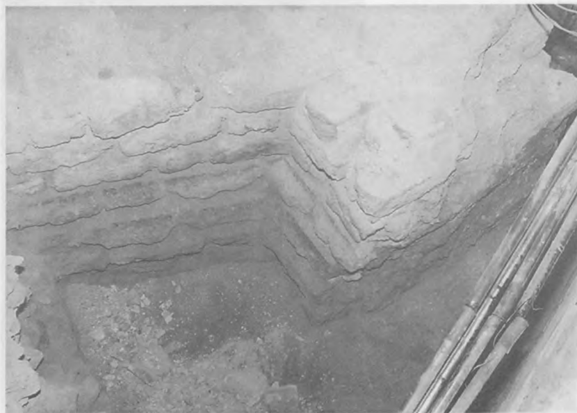
Fot. 8. Relikty glazurowanego gzymsu cokołu przy północno-wschodniej przyporze pierwszego kościoła. Fot. P. Witkowski
