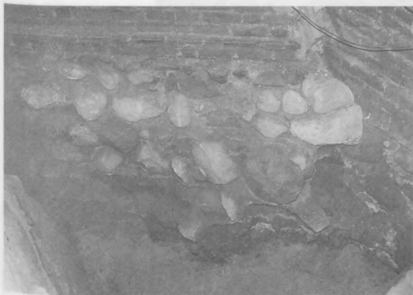
Fot. 5. Fundament muru pierwszego kościoła w wykopie I skutego (od prawej strony) w celu posadowienia ściany południowej obecnego prezbiterium. Ponad fundamentem, na drugiej warstwie cegieł widoczny ślad po drewnianej podłodze. Fot. W. Fidos
