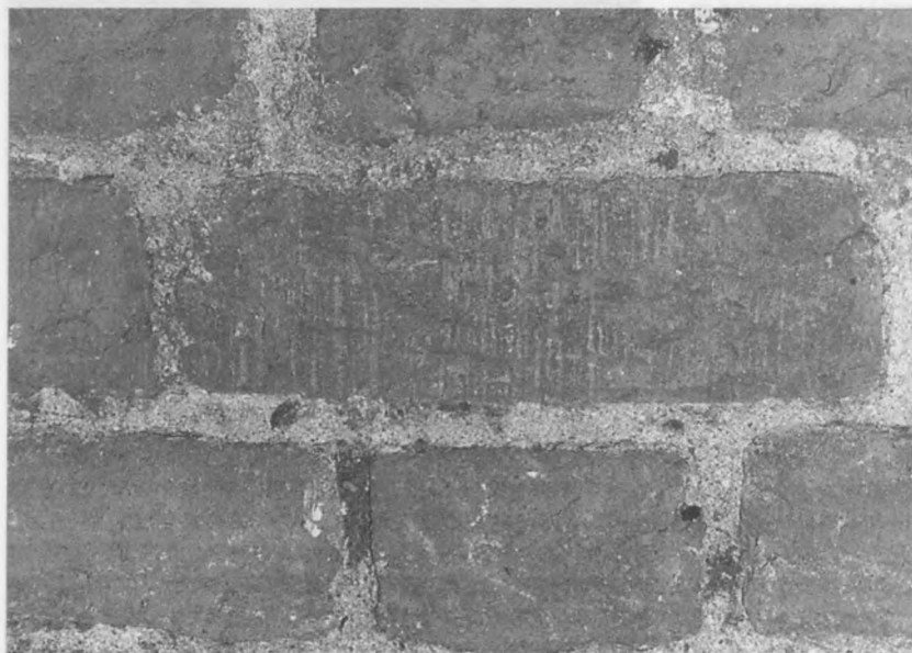
Fot. 16. Zbliżenie jednej z cegieł w murze pierwszego kościoła z widocznymi pionowymi rysami. Fot. W. Fidos
