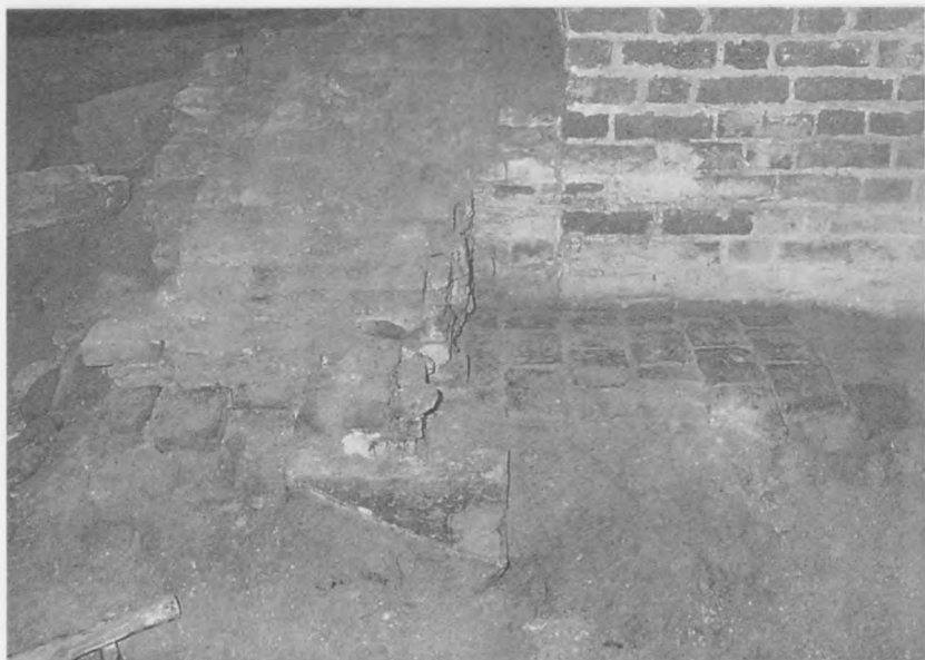
Fot. 4. Fragment glazurowanej posadzki przy podmurówce pod mensę oltarzową w obecnym prezbiterium oraz relikty stopni ceglanych do ołtarza. Fot. M. Furmaniuk
