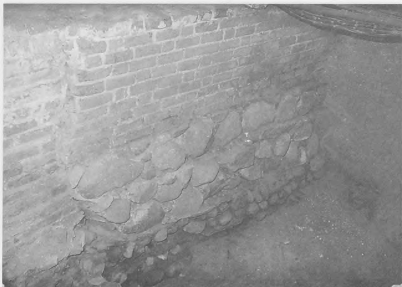
Fot. 9. Lico wewnętrzne muru północnego pierwszego kościoła ze skuciem pod rozbudowany fundament łuku tęczowego obecnego prezbiterium (z lewej strony) w wykopie III. Fot. P. Witkowski
