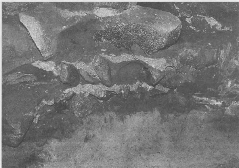
Fot. 6. Zbliżenie fragmentu dolnych partii fundamentu pierwszego kościoła z widocznymi warstwami gliny i piasku pomiędzy kamieniami. Fot. W. Fidos
