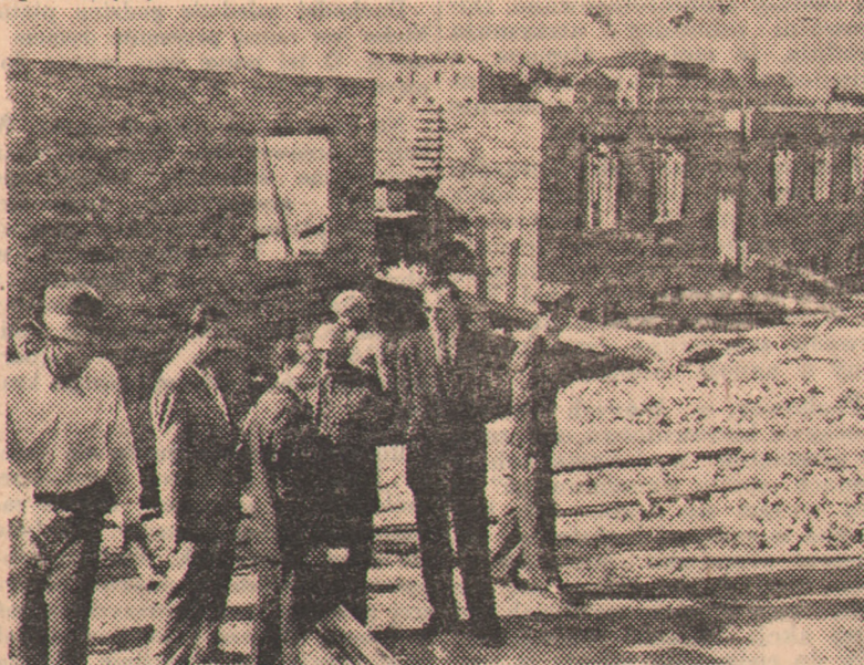
Prezydent Łodzi Minor wraz z wiceprezydentem mgr Sobolem oraz dziennikarzami zwiedza teren budowy nowych bloków mieszkalnych na Starym Mieście.
