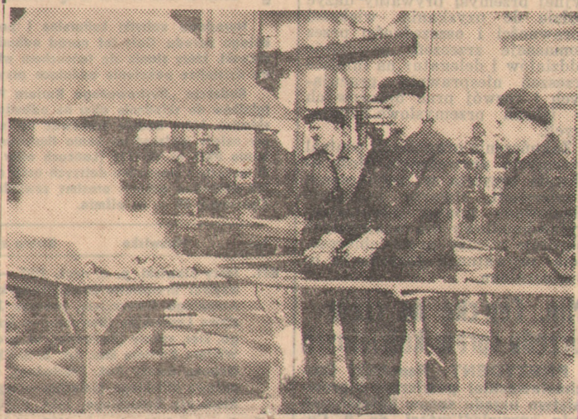
W kadłubowni Stoczni Gdyńskiej widać pracę nad przygotowaniem materiału dla odbudowywanego wraku s/s „Kopernik”. Statek oddany zostanie do eksploatacji w lutym 1950 r. Na zdjęciu: grupa młodych kowali z brygady młodzieżowej stoczniowców przy pracy w kadłubowni. (Patrz reportaż na str. 3).
