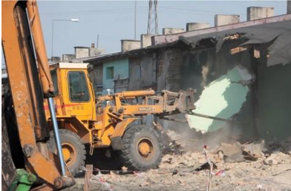
Rozbiórka Abisynii w 2015 r. Fot. P. Bilski
