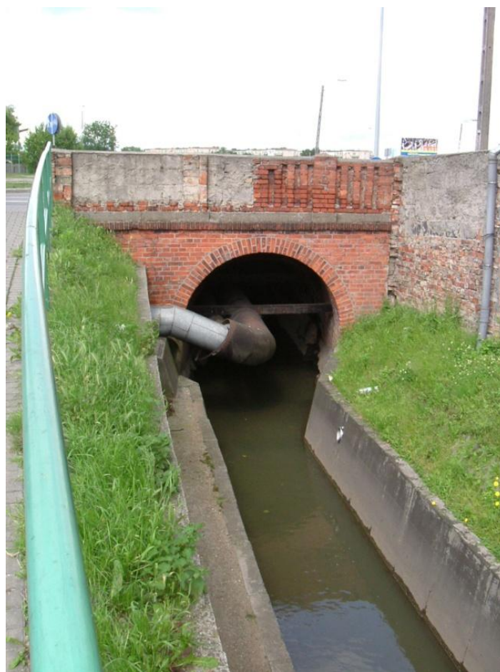
4. Krowi Most. Stan z ok. 2014 r. Fot. M. Szajerka.
