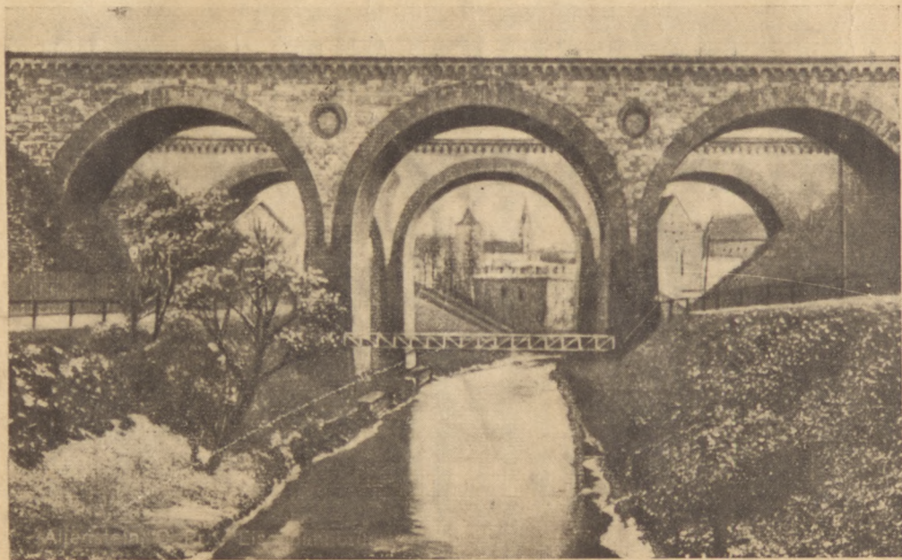
Most kolejowy z widokiem na Olsztyn
