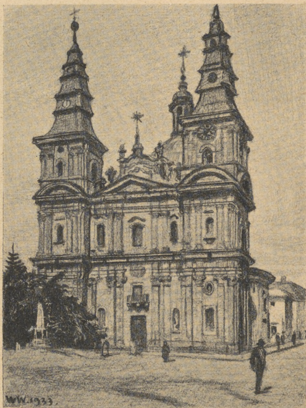
Obr. 464. — Kościół Dominikanów w Tarnopolu. Dachy przypominają chińszczyznę.
