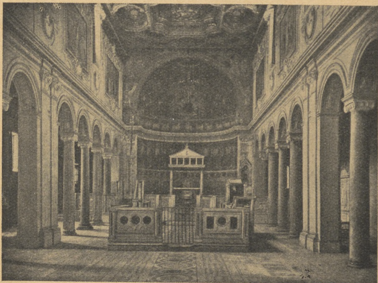
Obr. 218. — Wnętrze bazyliki św. Klemensa w Rzymie. Sufit barokowy.
