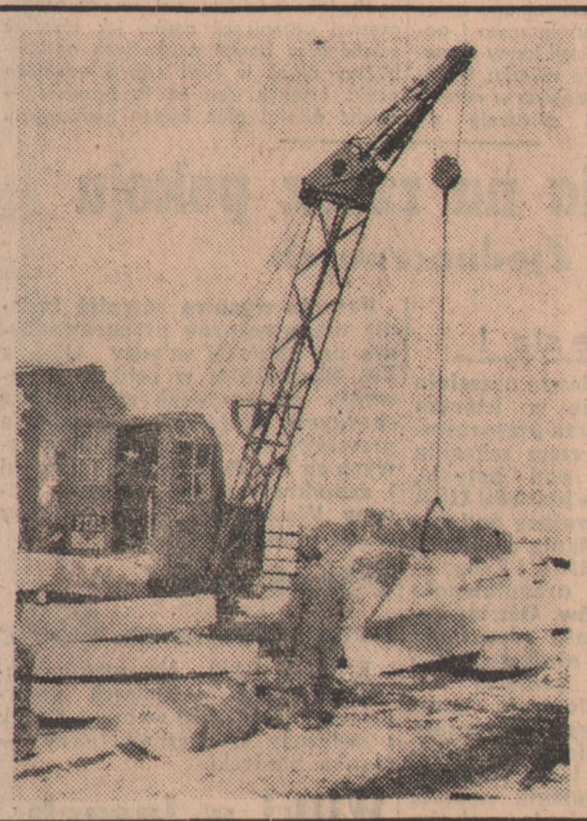
W Stolicy, przy al. Zwirki i Wigury powstaje cmentarz żołnierzy radzieckich poległych o wyzwolenie Warszawy. Na cmentarzu stanie granitowy obelisk o wysokości 37 m. Na zdjęciu: prace przy zwózce kamienia na grobki. Foto: Film Polski
