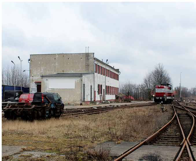
Ryc. 81. Budynek socjalno-warsztatowy nieopodal wiaduktu nad ul. Tucholską. W tle manewrująca lokomotywa SU42-508. Fot. Damian Otta, 29 lutego 2016 roku.
