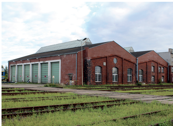
Ryc. 91. Stara hala parowozowni po przebudowie. Fot. Damian Otta, 12 września 2017 roku.
