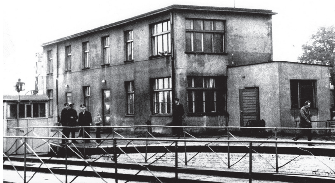
Ryc. 69. Budynek dyspozytorni po rozbudowie w 1963 roku. Źródło: J. Czyż, Cz. Kukliński, T. Patyński.
