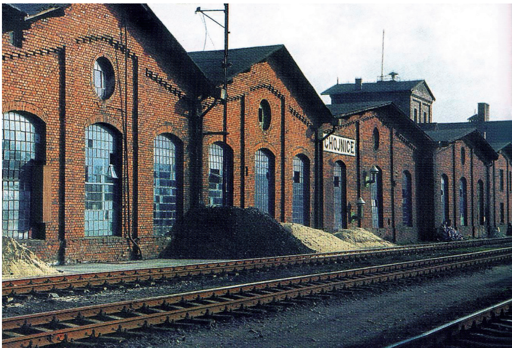
Ryc. 90. Pięciosegmentowa hala parowozowni przed rozbiórką w 1996 roku. Źródło: K. Wiśniewski, Ostatnie polskie parowozownie.
