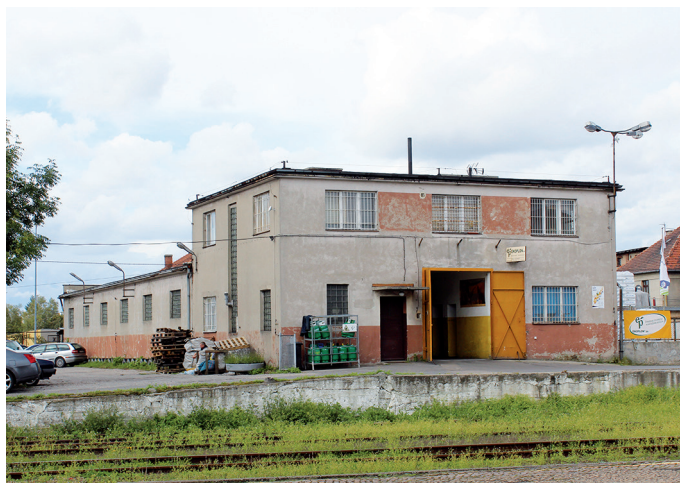
Ryc. 75. Budynek Magazynu Filialnego w Chojnicach w2017 roku. Fot. Damian Otta.
