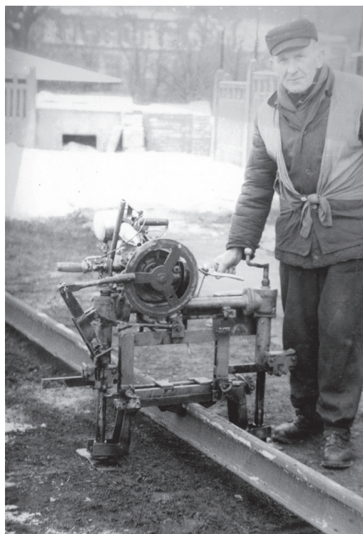
Ryc. 100. Piła do cięcia szyn z silnikiem spalinowym i jej twórca – Ignacy Werra. Źródło: J. Czyż, Kronika Klubu Techniki ...
