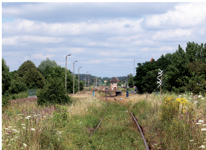
Ryc. 86. Wjazd na stację PKP w Więcborku od strony Nakła. Z lewej strony widoczna wolna przestrzeń na wiadukcie poszerzonym z myślą o rozbudowie układu torowego stacji. Fot. Damian Otta, 22 lipca 2017 roku.
