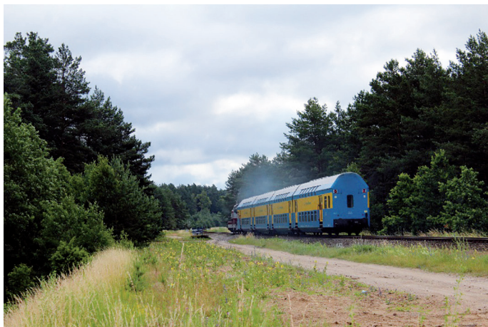
Ryc. 12. Nasyp kolejowy usypany pod cztery tory w okolicach Rytle. Fot. Damian Otta, 1 lipca 2017 roku.
