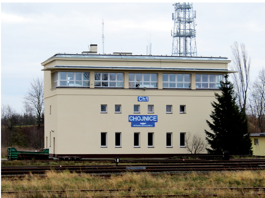
Ryc. 67. Nastawnia wykonawcza „Ch1” po remoncie w 2017 roku. Fot. Damian Otta.
