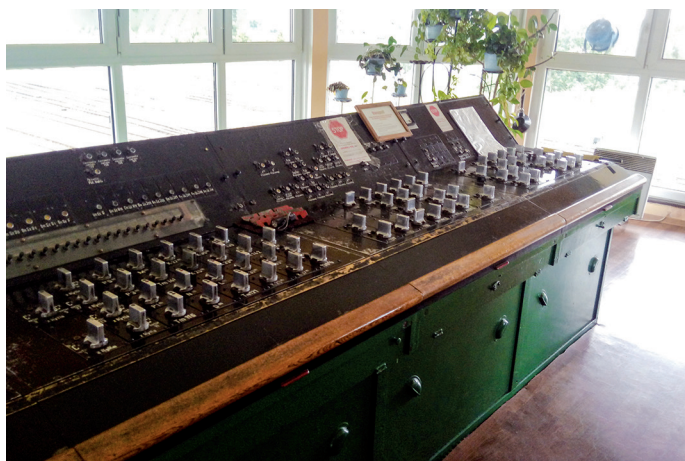
Ryc. 52. Nastawnica suwakowa czterorzędowa nastawni Ch. Fot. Damian Otta, 2017 rok.
