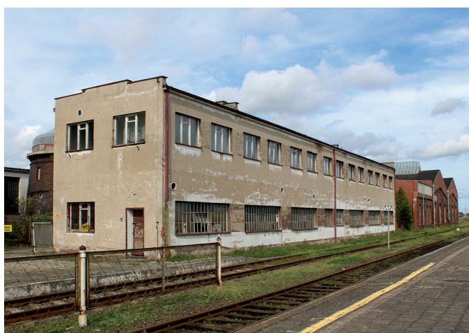
Ryc. 76. Budynek socjalno-warsztatowy przy peronie 3 w 2017 roku. Fot. Damian Otta.
