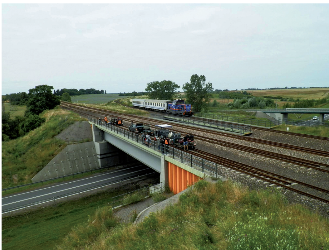
Ryc. 139. Drezyny podczas postoju na wiadukcie nad chojnicką obwodnicą. W tle pociąg TLK „Kociewie”. Fot. Janusz Kociński, 22 lipca 2017 roku.
