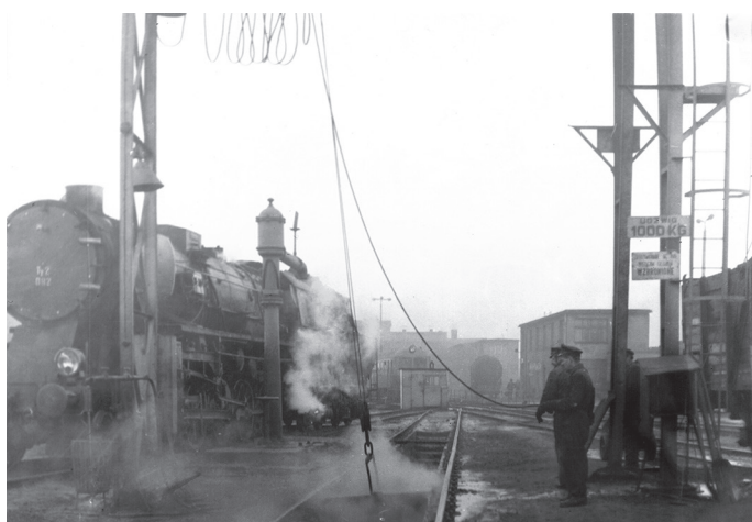
Ryc. 71. Dźwig bramowy ustawiony przy kanale oczyszczowym. W tle widoczny parowóz Ty2-682, obrotnica i budynek dyspozytorni. Źródło: Fotografia ze zbiorów Szkoły Podstawowej nr 3.
