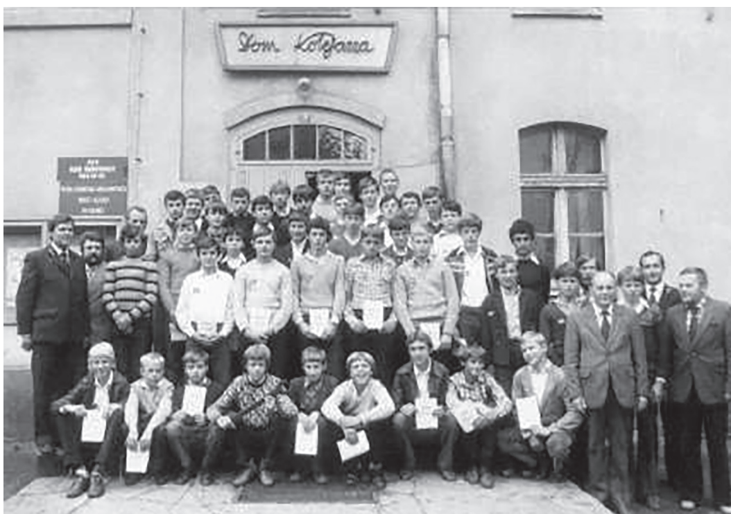
Ryc. 104. Wspólne zdjęcie przed Domem Kolejarza po akcie pasowania na uczniów kolejowych w dniu 11 września 1982 roku.
