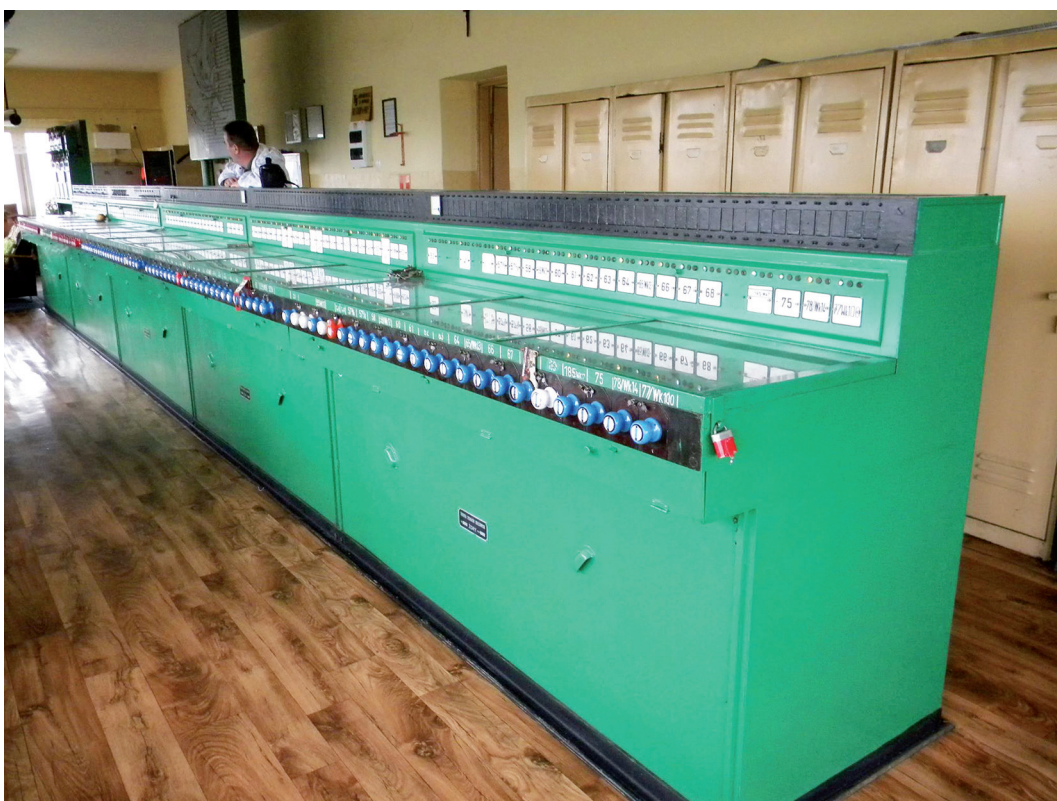
Ryc. 66. Nastawnica suwakowa jednorzędowa nastawni „Ch1”. Fot. Nikodem Wodowski.
