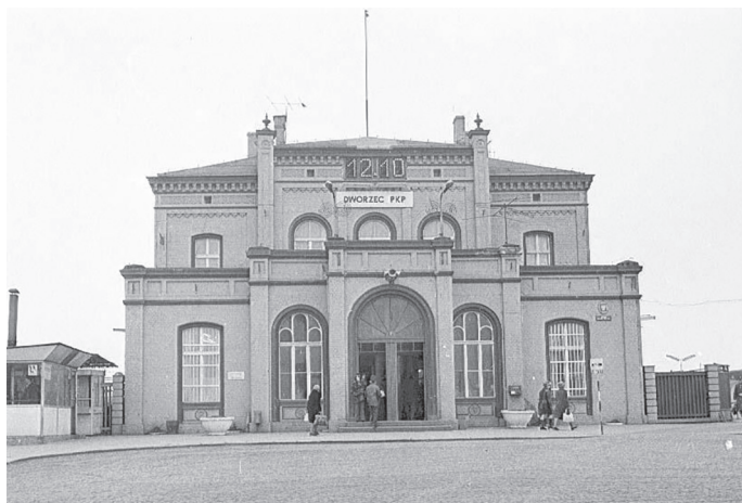
Ryc. 77. Dworzec PKP w Chojnicach z zainstalowanym zegarem elektronicznym.
