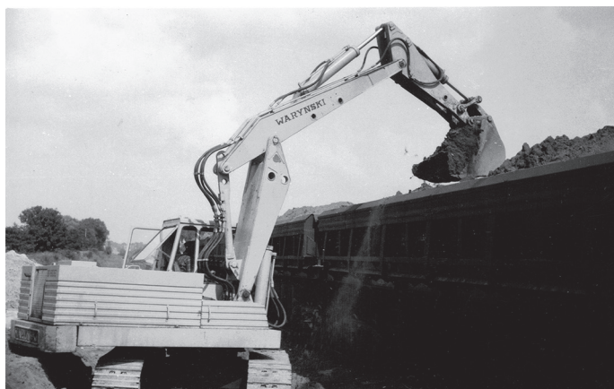
Ryc. 85. Załadunek urobku na wagony samowyładowcze typu 904V, przy wykorzystaniu koparki „Waryński” K-606 na szlaku Wapno – Kcynia przy budowie drugiego toru.
