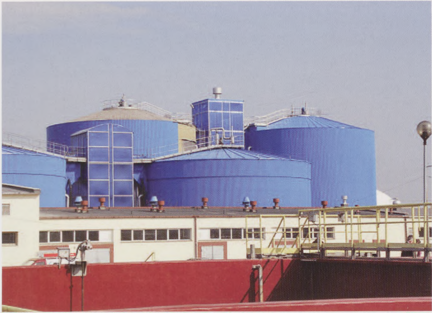
Nowe obiekty na modernizowanej oczyszczalni ścieków w Fordonie
