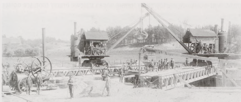
Maszyny parowe w czasie pierwszego etapu prac. Budowa wykopu pod filar mostu na terenie zalewowym. Zdjęcie z początku budowy w 1891 roku
