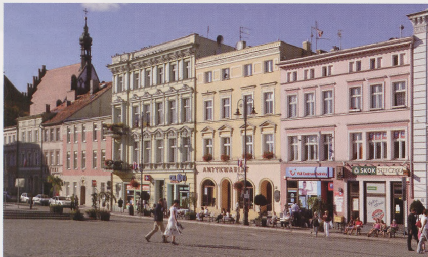
Stare kamienice czekają na remont...
