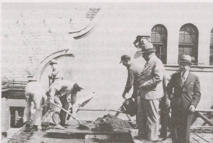
Podczas nadzorowania prac na budowie: Jan Kossowski – pierwszy z prawej
