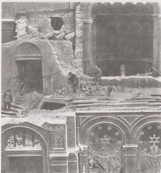
Rozbiórka bydgoskiej synagogi, 1939/1940 r. Fot. Włodzimierz Kaldowski
