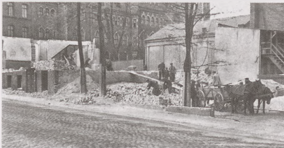
Rozbiórka budynku masonerii, 1940 r. Fot. Włodzimierz Kaldowski
