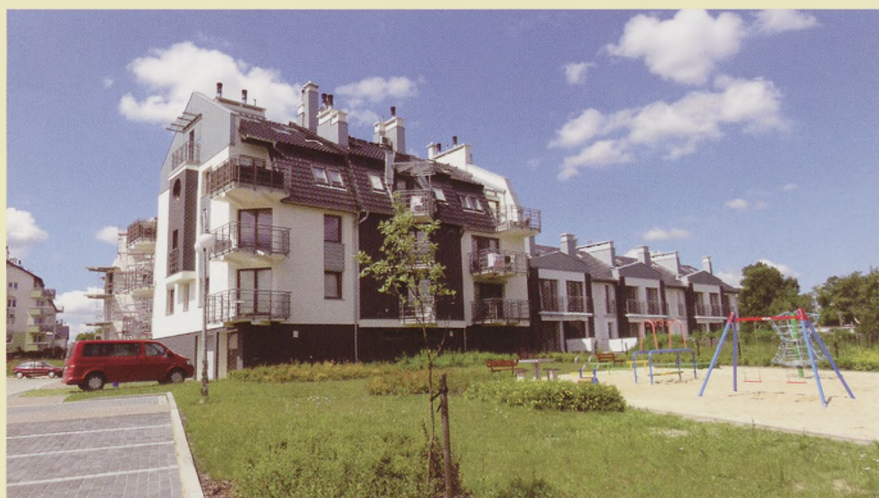
Budynek wielorodzinny oraz domy szeregowe przy ul. Łobżenickiej
