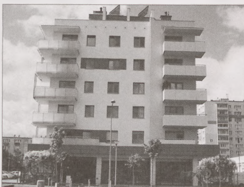
Budynek na medal przy ul. Ogrody 14. Widok od strony miasteczka rekreacyjnego. Na dachu fragment ogniw fotowoltaicznych
