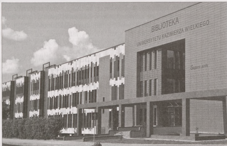
Nowy gmach Biblioteki Głównej UKW przy ul. M. Ogińskiego. Fot. Archiwum
