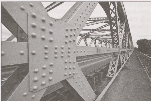
Remontowane wiosną 2010 roku trzy przęsła zalewowe w Jarosławiu na Sanie. Fot. Maciej Kulesza
