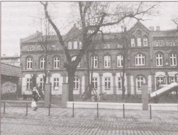
Szkoła przy ul. Dworcowej, „pierwsza moja uczelnia”. Najniższe roczniki zajmowały poddasze, czyli tzw. kur-nik, ale to tu pani Daszutowa uczyła moją klasę poprawnej polszczyzny. Obecnie w budynku mieści się Młodzieżowy Dom Kultury. Fot. Autor
