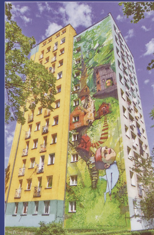
Mural na budynku przy ul. 3 Maja 16
