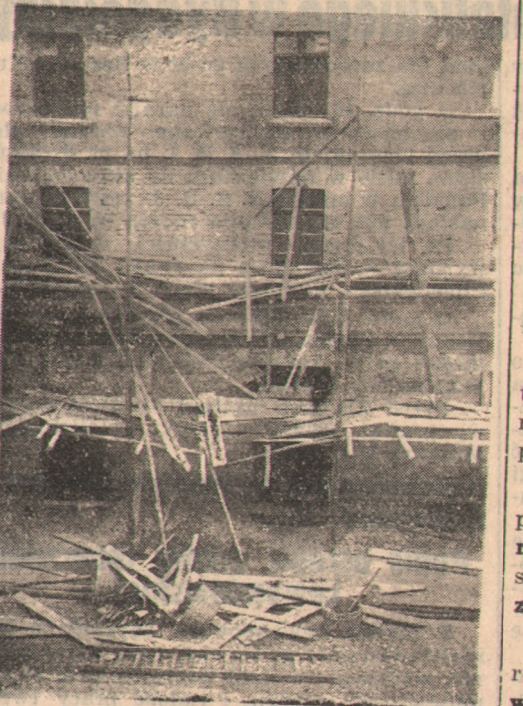
Widok na rusztowanie po katastrofie.
