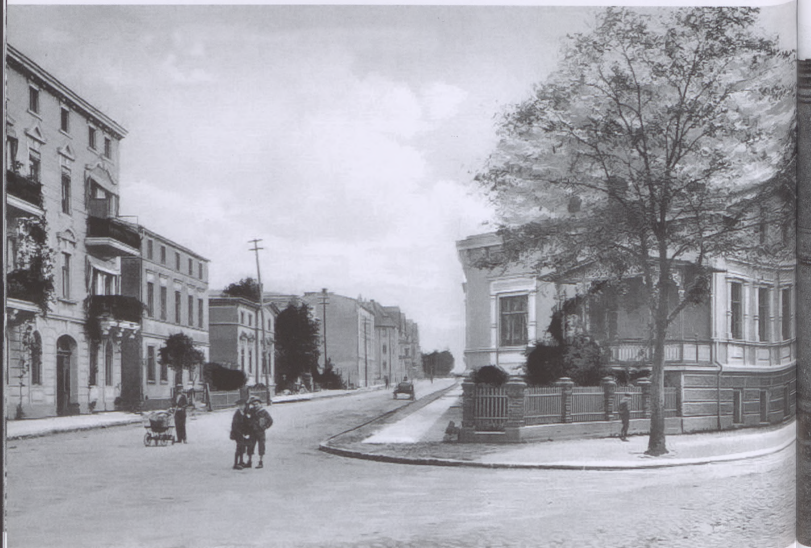
Podobne ujęcie, ale ukazujące południową elewację budynku przy Bahnhofstrasse 45 (obecnie: Dworcowa 1)
