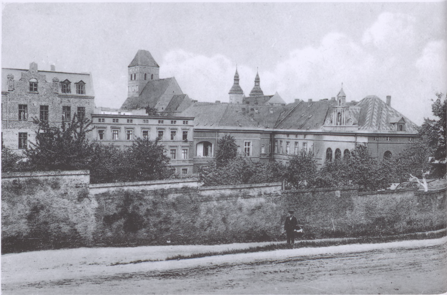
Zakład św. Boromeusza. Prawdopodobnie rok 1909 lub 1910. Dom św. Franciszka w trakcie budowy. Widać elewację jeszcze bez tynków.
