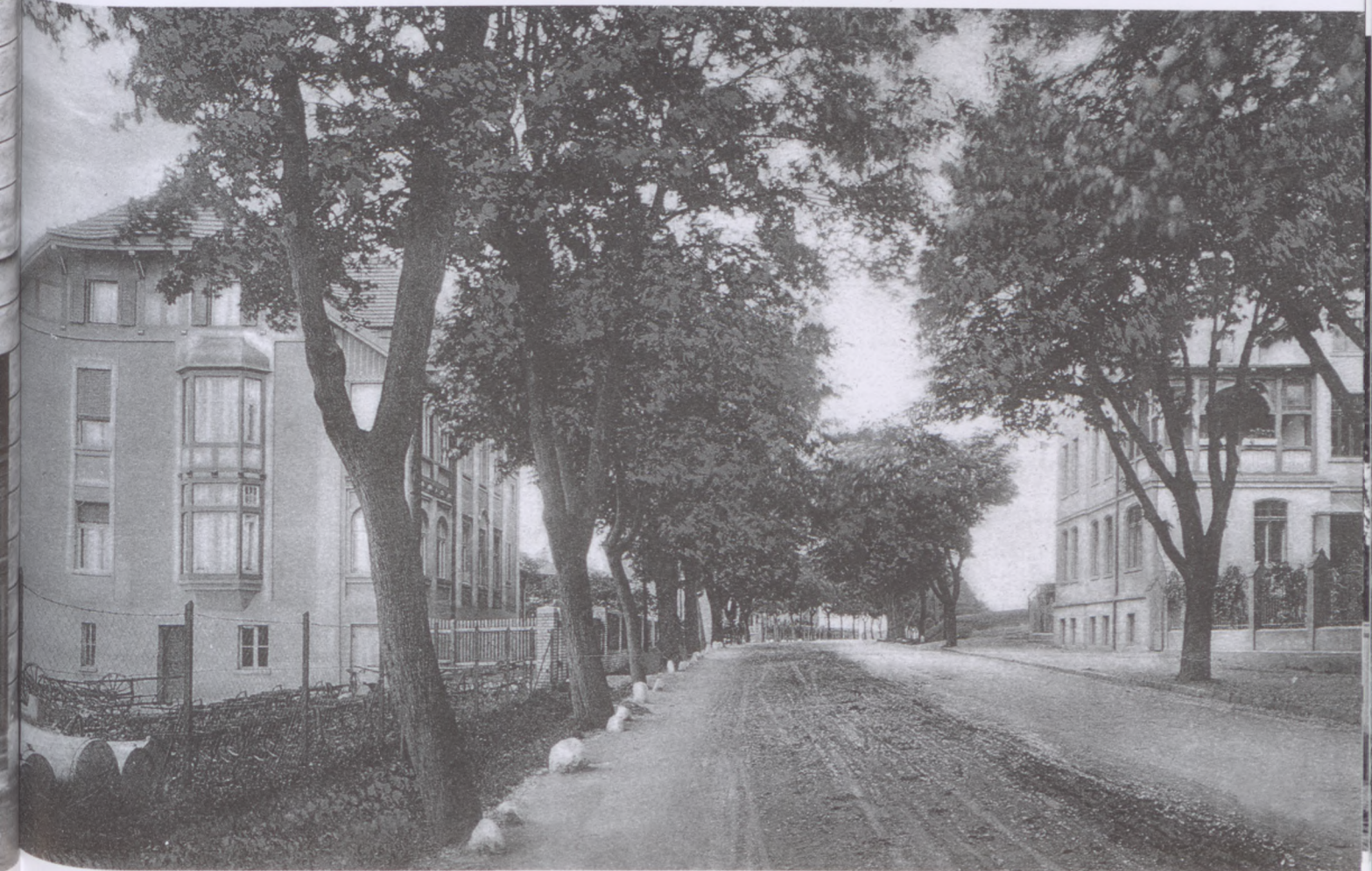
Ulica Człuchowska (Schlochauerstrasse). Inspekcja budowlana (bauinspektion). Po prawej obecnie Człuchowska 38.
