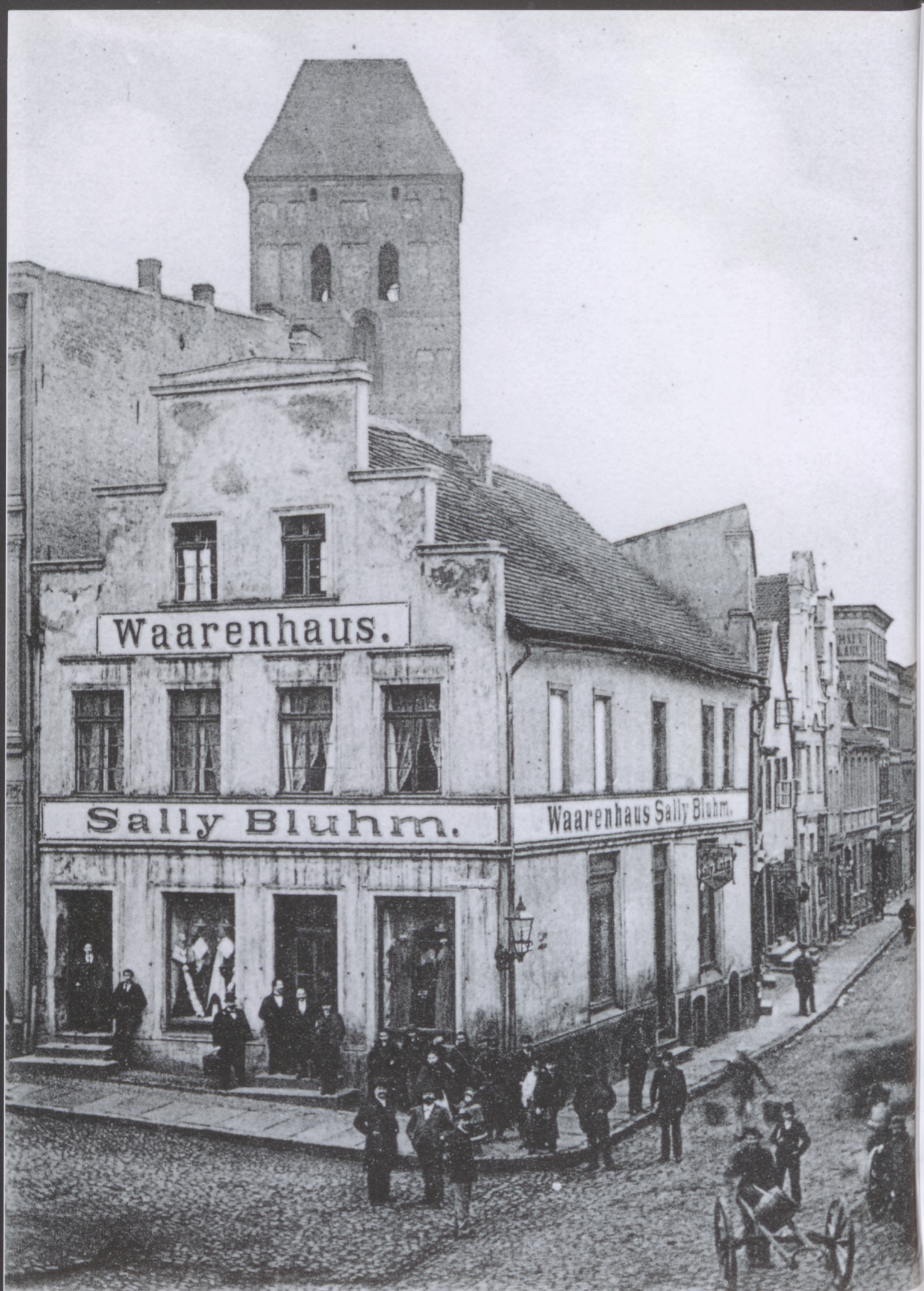
Dom towarowy Sally Bluhm. Południowo-wschodni narożnik rynku. Ostatnia dekada XIX wieku.
