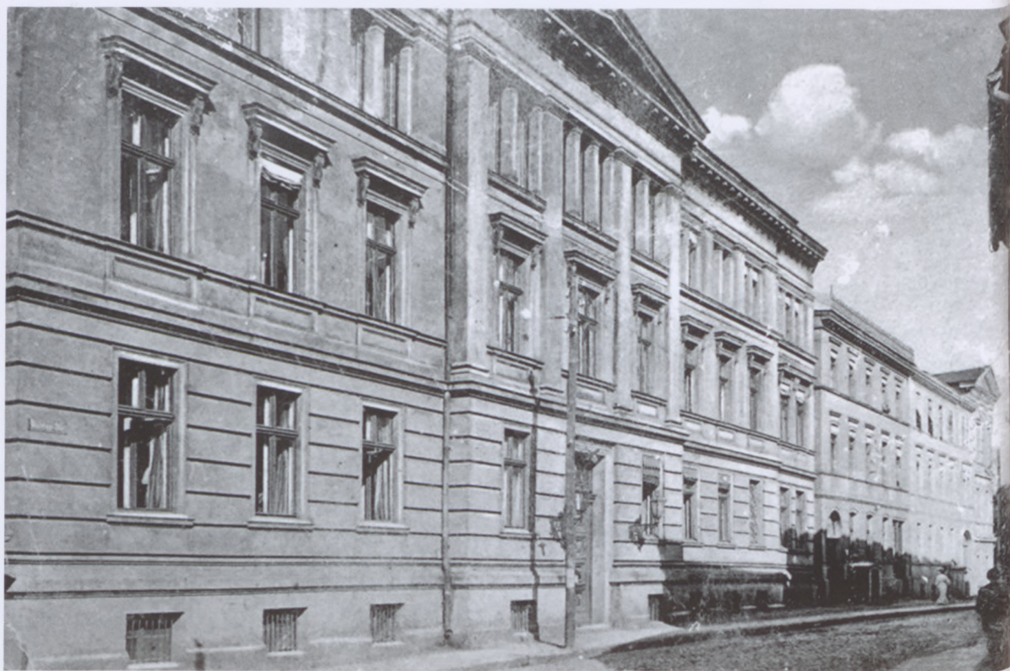
Południowa elewacja wybudowanego w 1878 roku budynku sądu.
