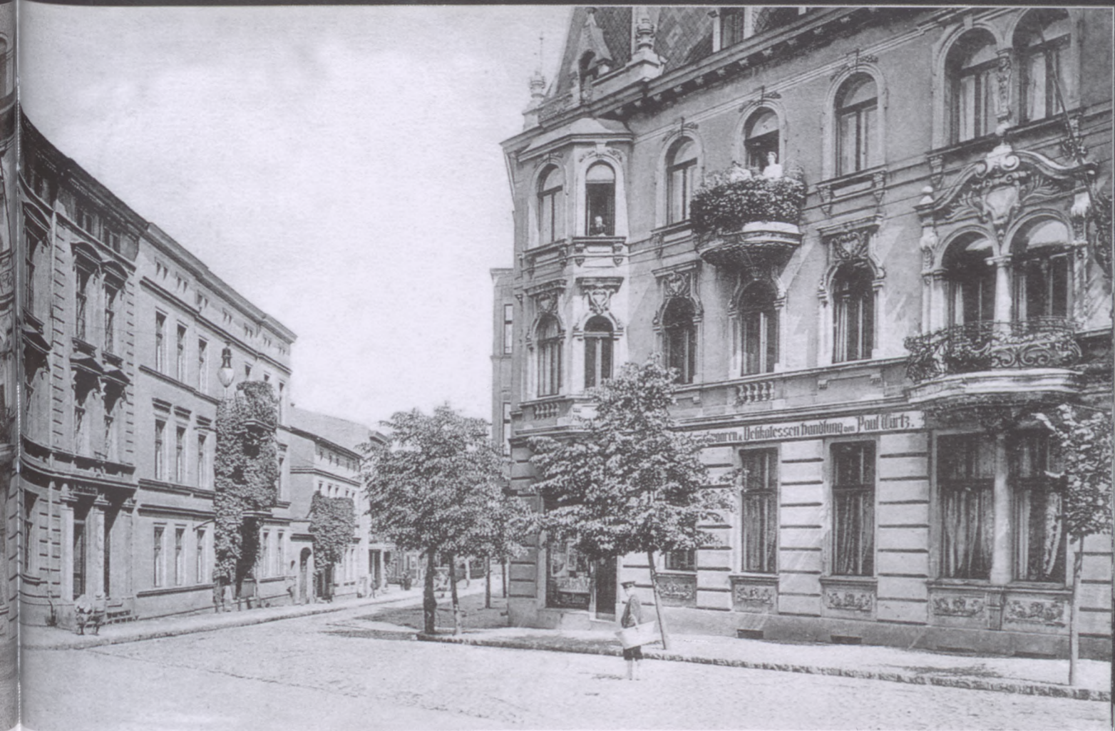
Na parterze był sklep kolonialny i delikatesy. Z lewej strony kamienice nr 20 (nie istnieje) i 18.
