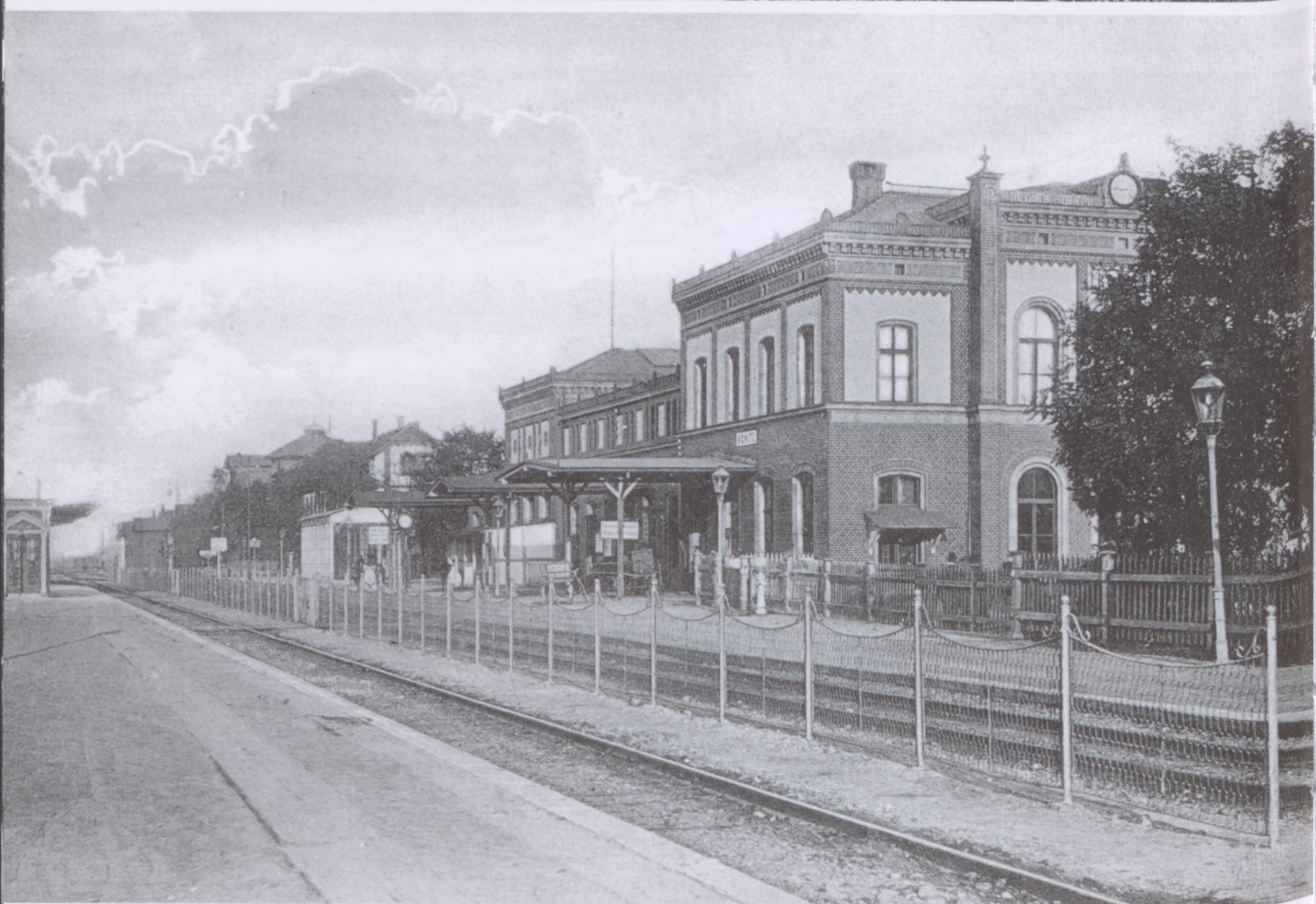
Na zdjęciach powyżej północna strona chojnickiego dworca kolejowego. Na stronie sąsiedniej strona południowa.
