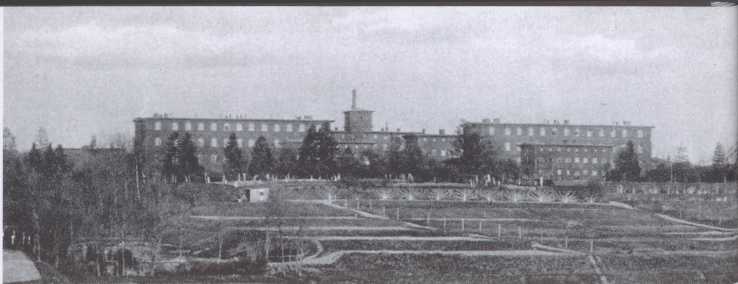
Kompleks budynków zakładu poprawczego wybudowanego w 1885 roku.
