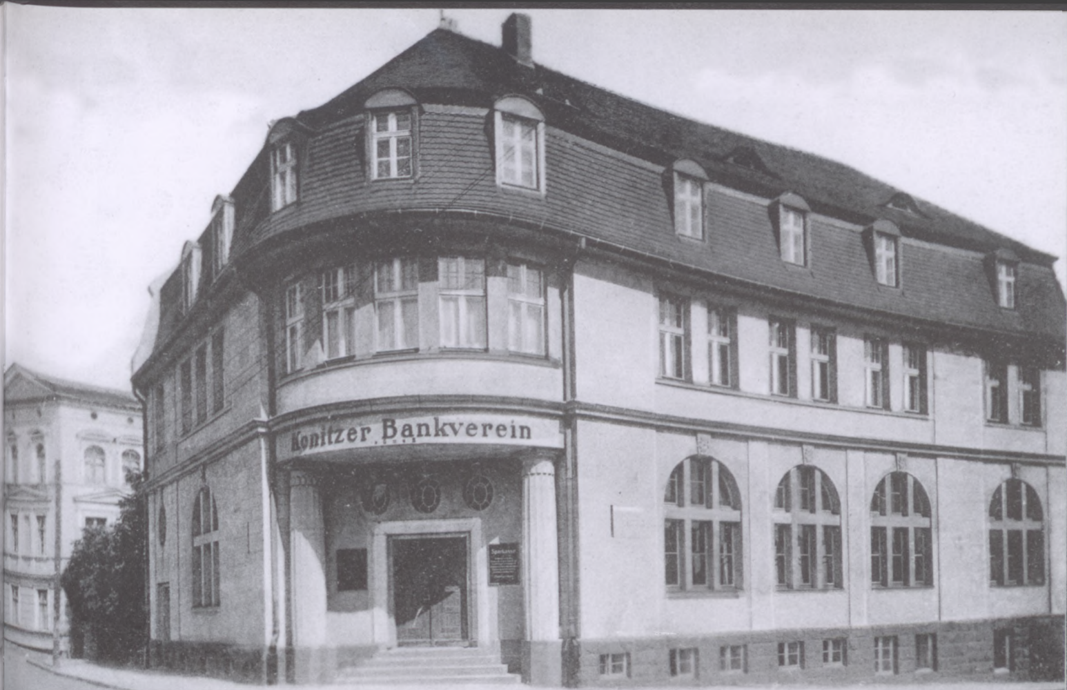
Niemiecki Bank Spółdzielczy. Konitzer Bankverein. Powstał w 1859 roku, a widoczną na zdjęciu siedzibę wybudowano w 1914.
