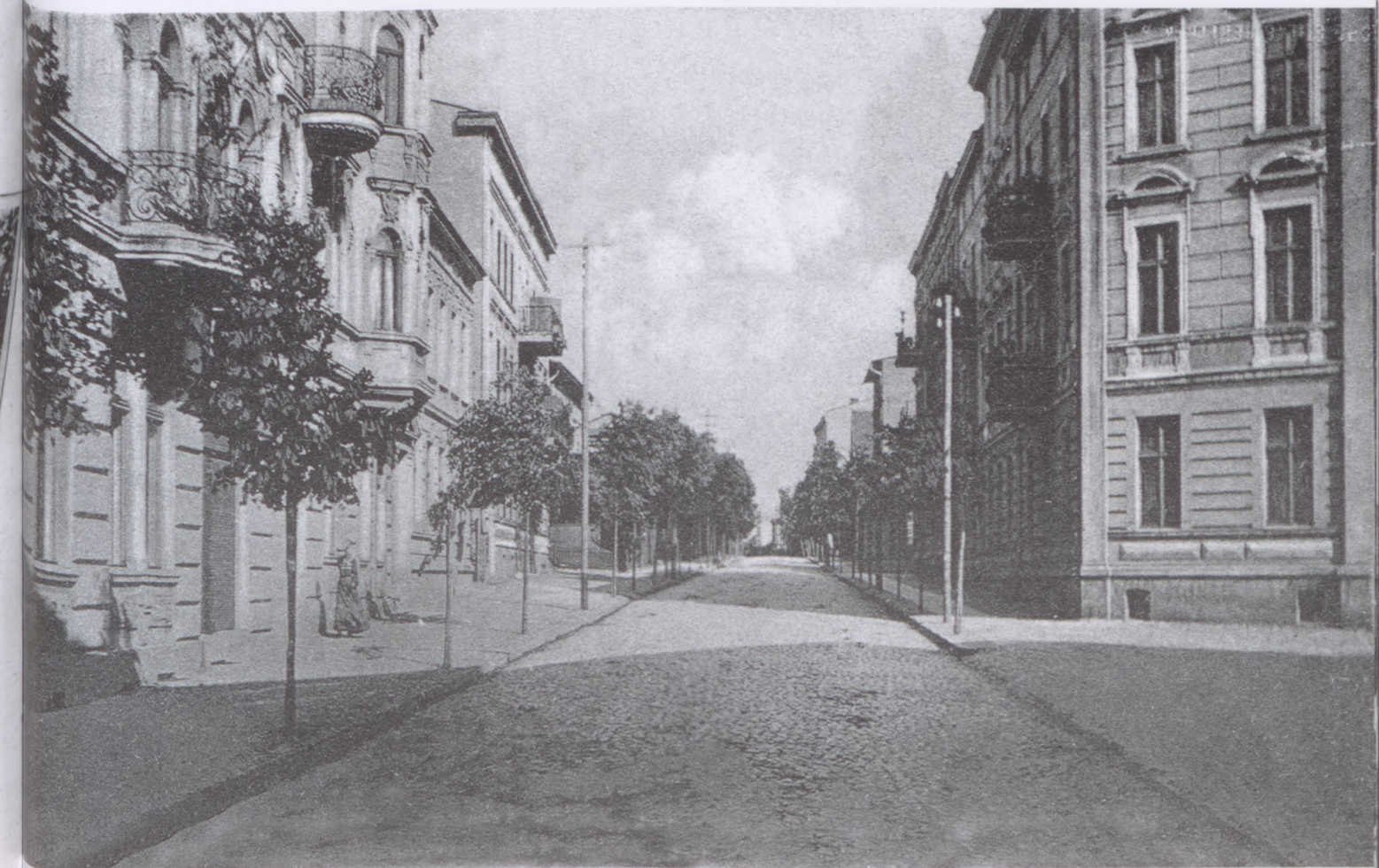
Jedno z nielicznych zdjęć pokazujących elewację narożnej kamienicy nr 22. Pocztówka z obiegu: 21.10.1904.
