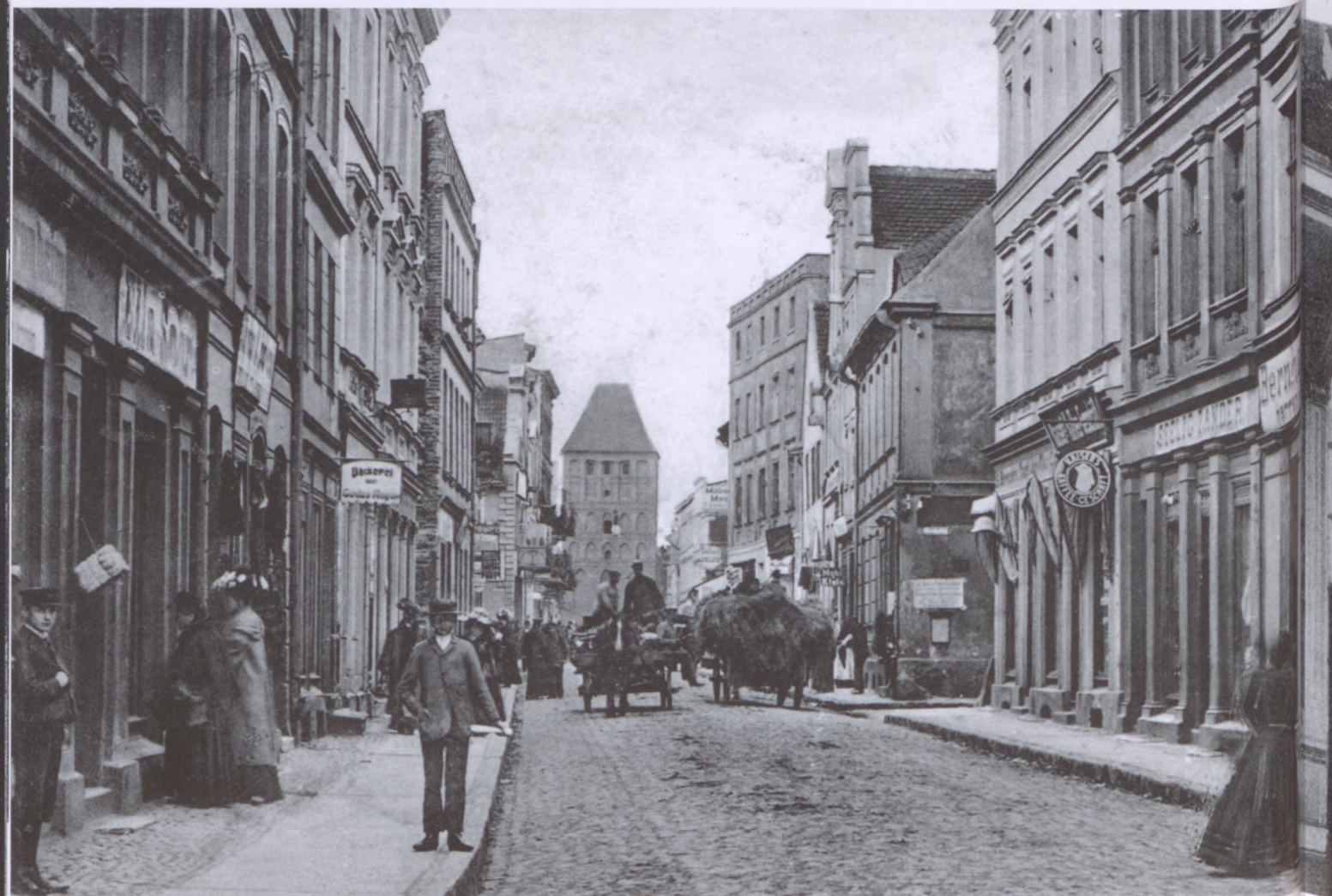
To samo miejsce, nieznacznie bliżej do płyty Starego Rynku.
