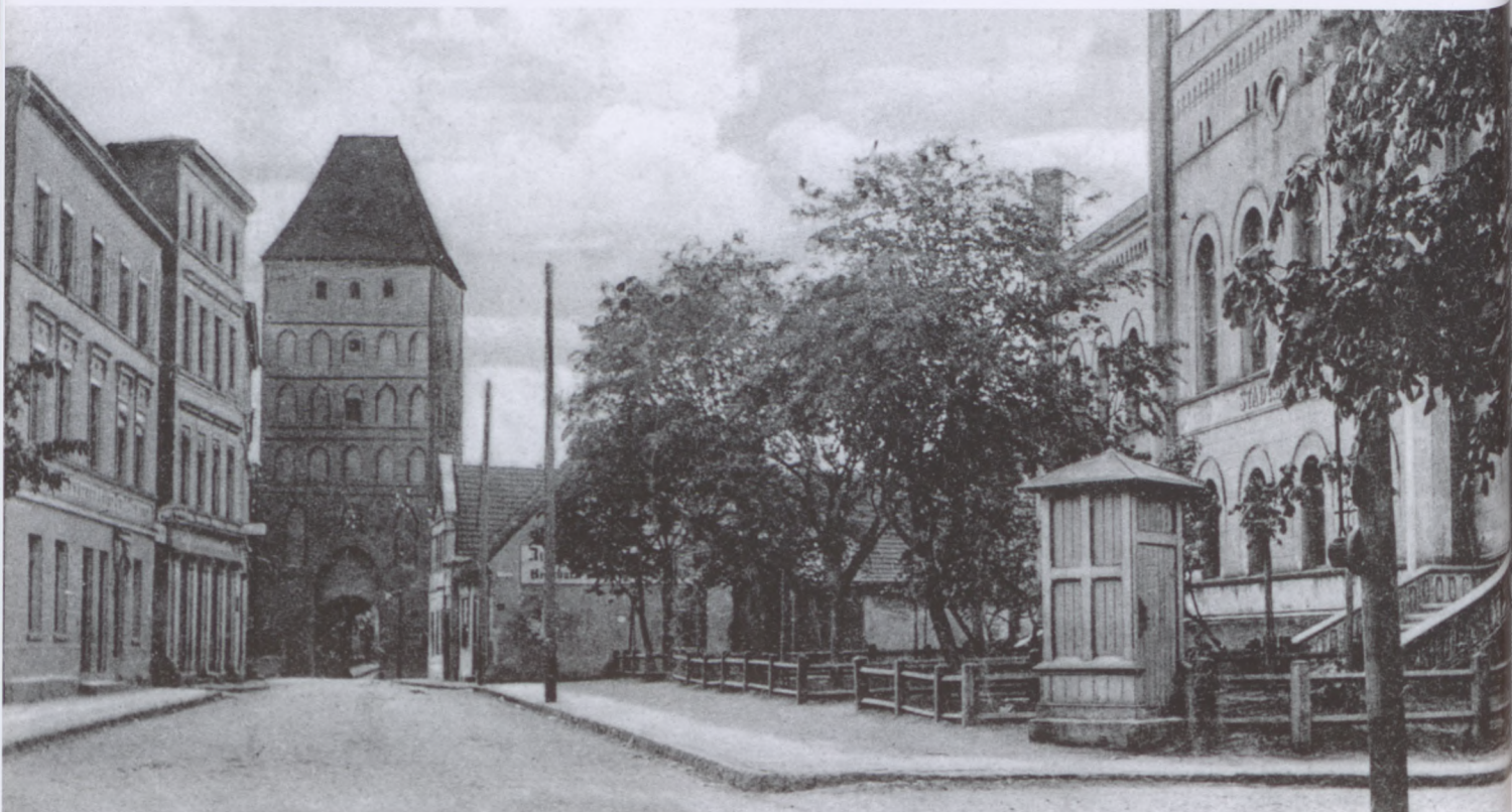
Brama Człuchowska i wybudowana w 1861 szkoła miejska. Przed szkołą zwraca uwagę publiczna toaleta.
