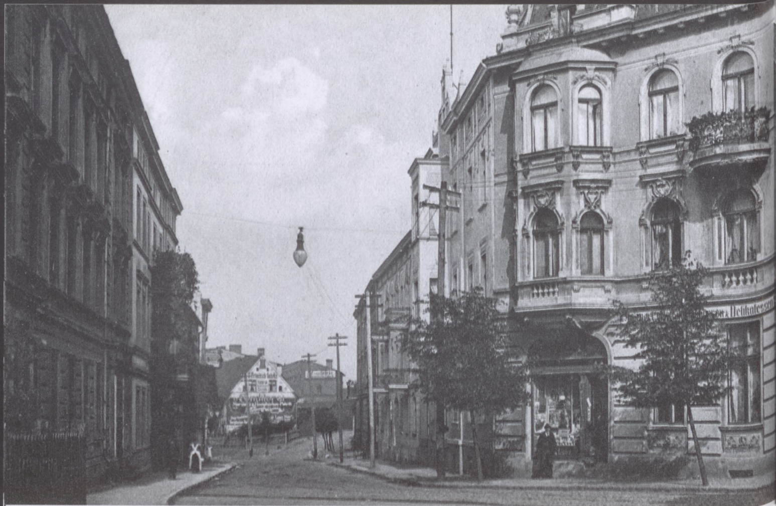
Po elektryfikacji w krajobrazie chojnickich ulic pojawiły się wysokie słupy z przewodami elektrycznymi i telefonicznymi.
