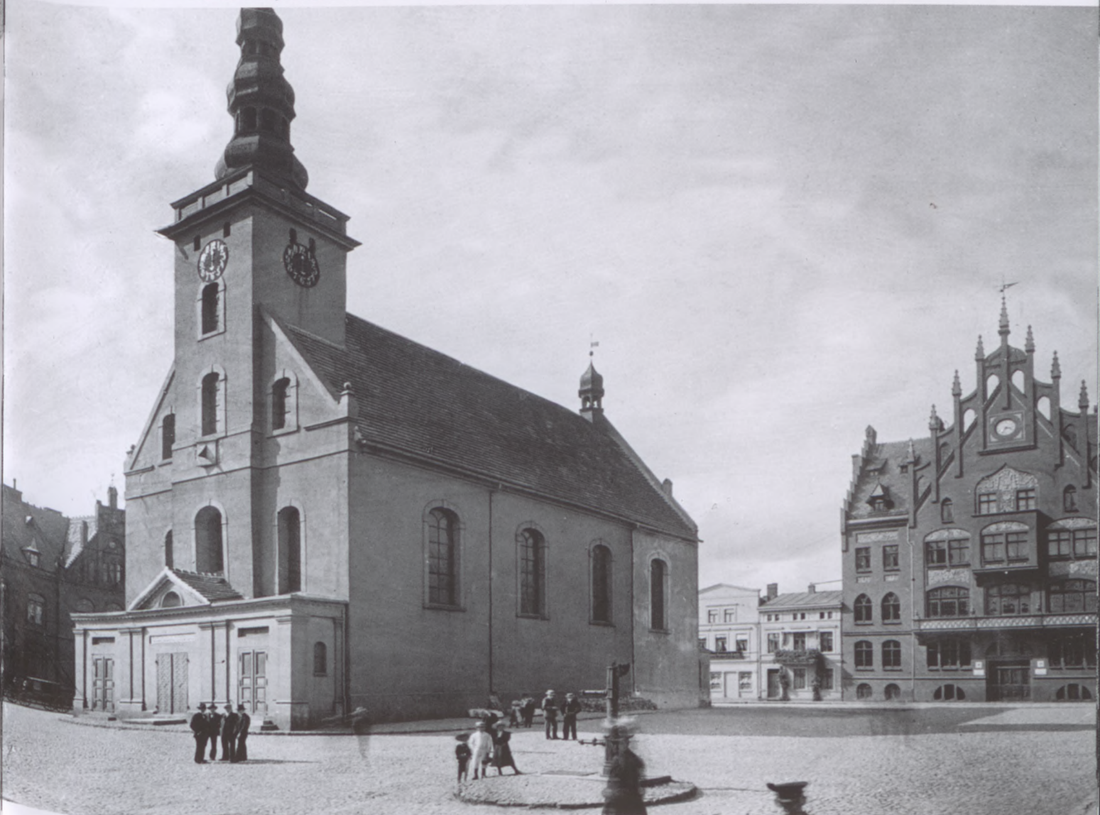
Zakończono rozbiórkę starego ratusza. Pod ścianą kościoła leżą jeszcze ostatnie cegły.
