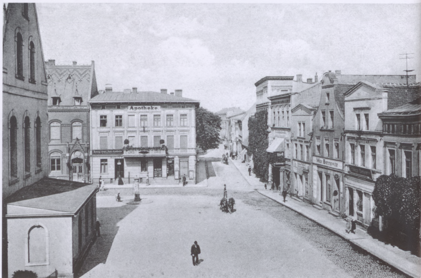
Północno-zachodni narożnik rynku. Kamienica nr 7 mieszcząca aptekę zyskała balkon.
