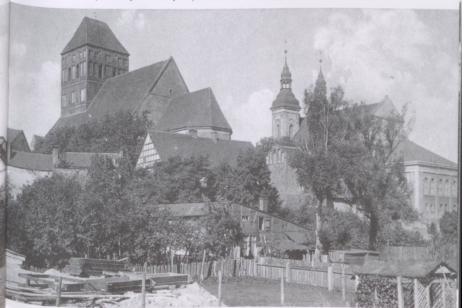
W miejscu osuszonego Jeziora Cegielnianego (Zielonego) założono ogrody i postawiono budynki gospodarcze. Zdjęcie wykonano przed 1908.
