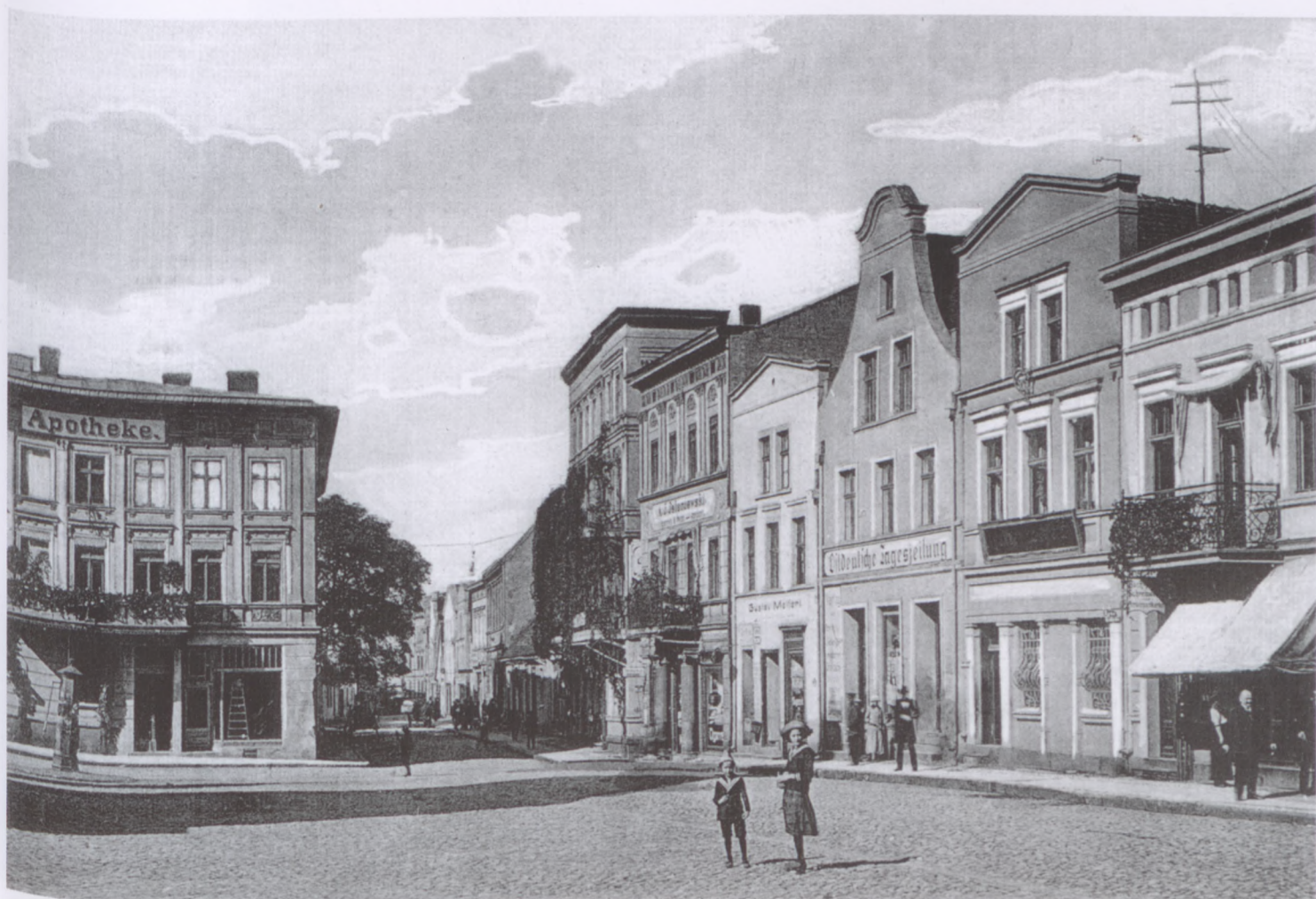
Kamienica nr 7 po przebudowie parteru zyskała duże okno wystawowe.
