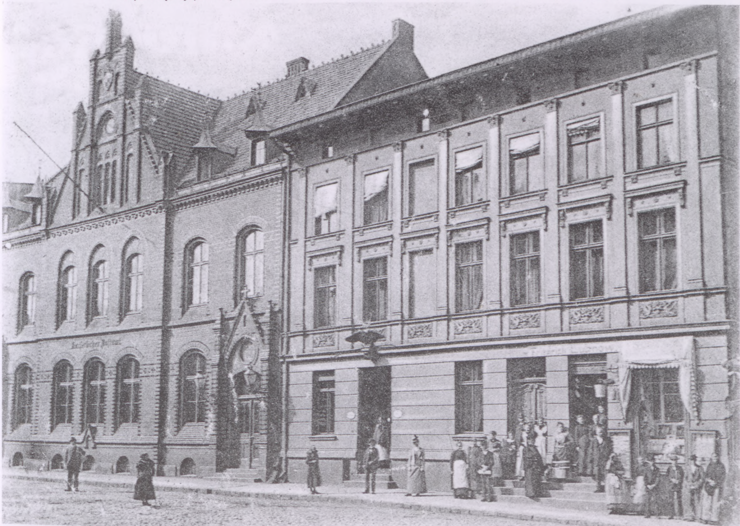
Kamienica Rynek 7 w pierwotnej formie architektonicznej.
