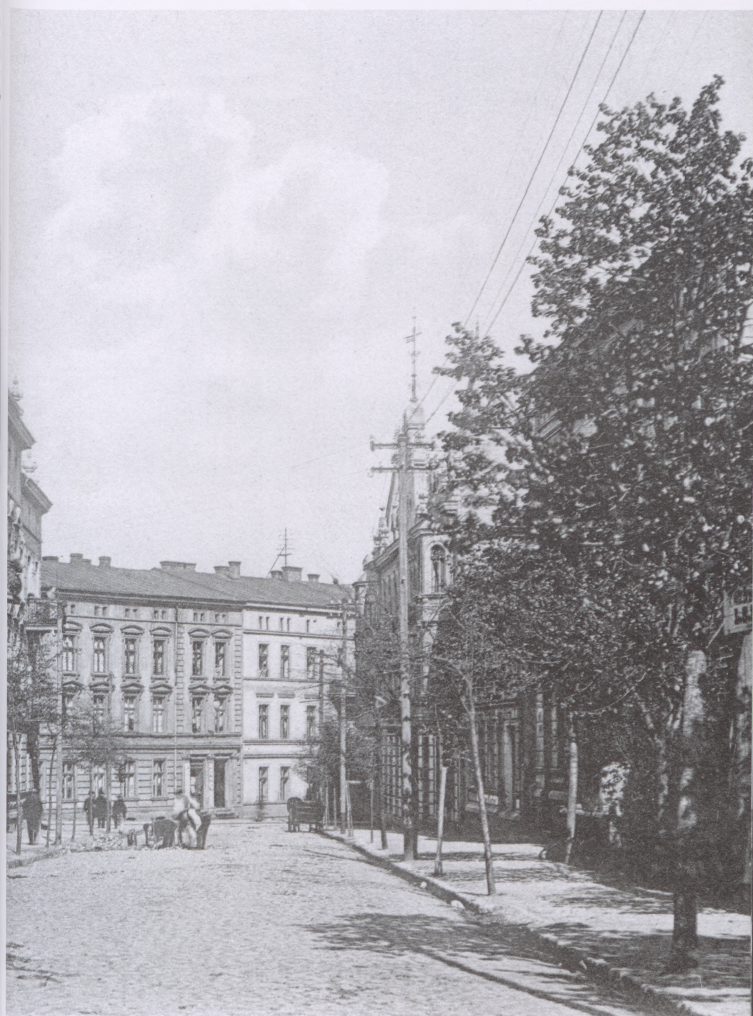
W środkowej części zdjęcia widoczne kamienice 20 i 18.
