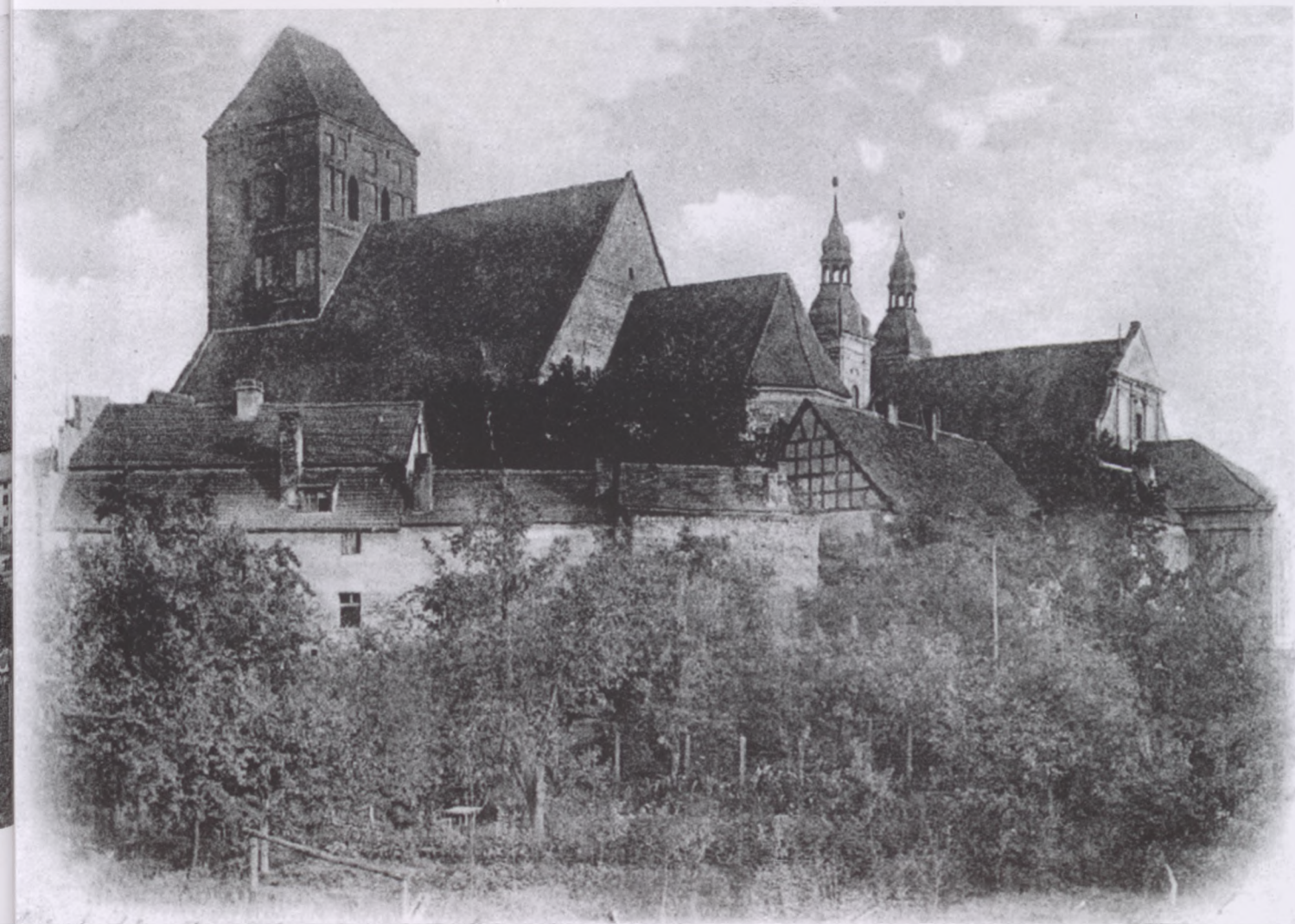
Widok na chojnickie kościoły. Na pierwszym planie ściana boczna kamienicy Jączyńskiego (dzisiaj: Kościuszki 21).
