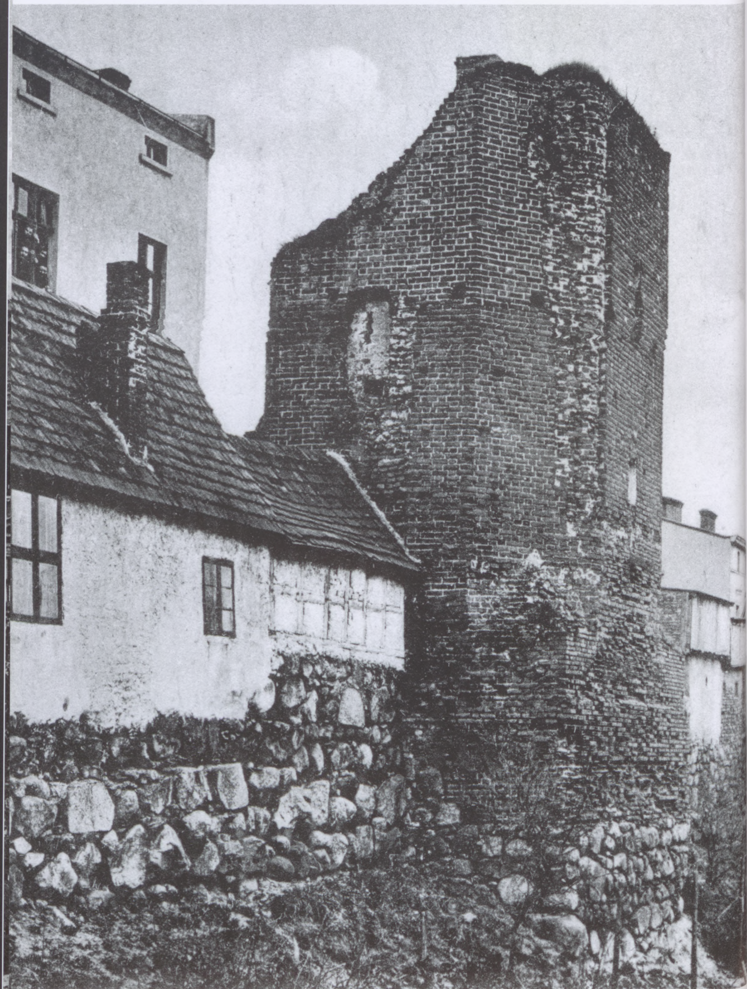
Odcinek murów i fosy pomiędzy bramami Człuchowską a Młyńską (nieistniejąca od 11 maja 1838).
