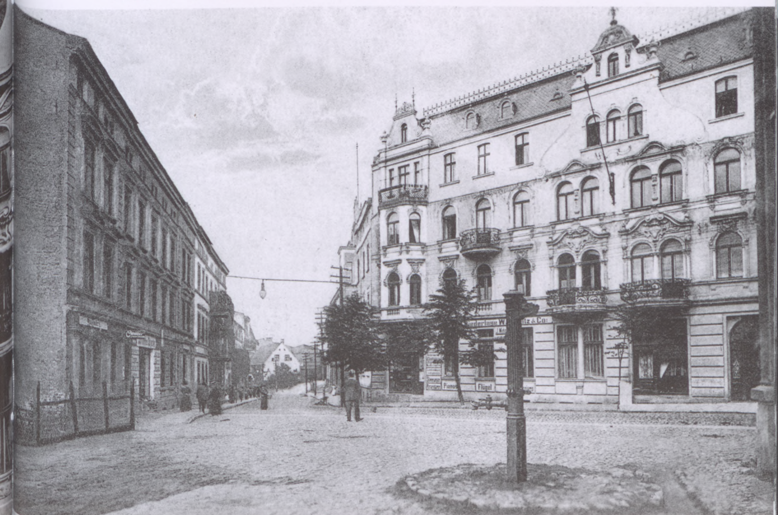
Kamienica po przebudowie. Dodano trzecie piętro.
