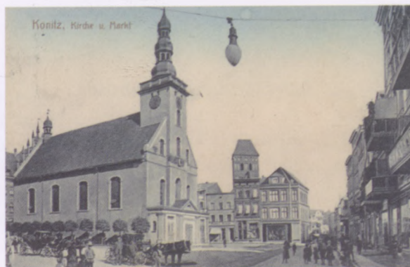
Pocztówka zmodyfikowana. Dostawiono narożny budynek.
