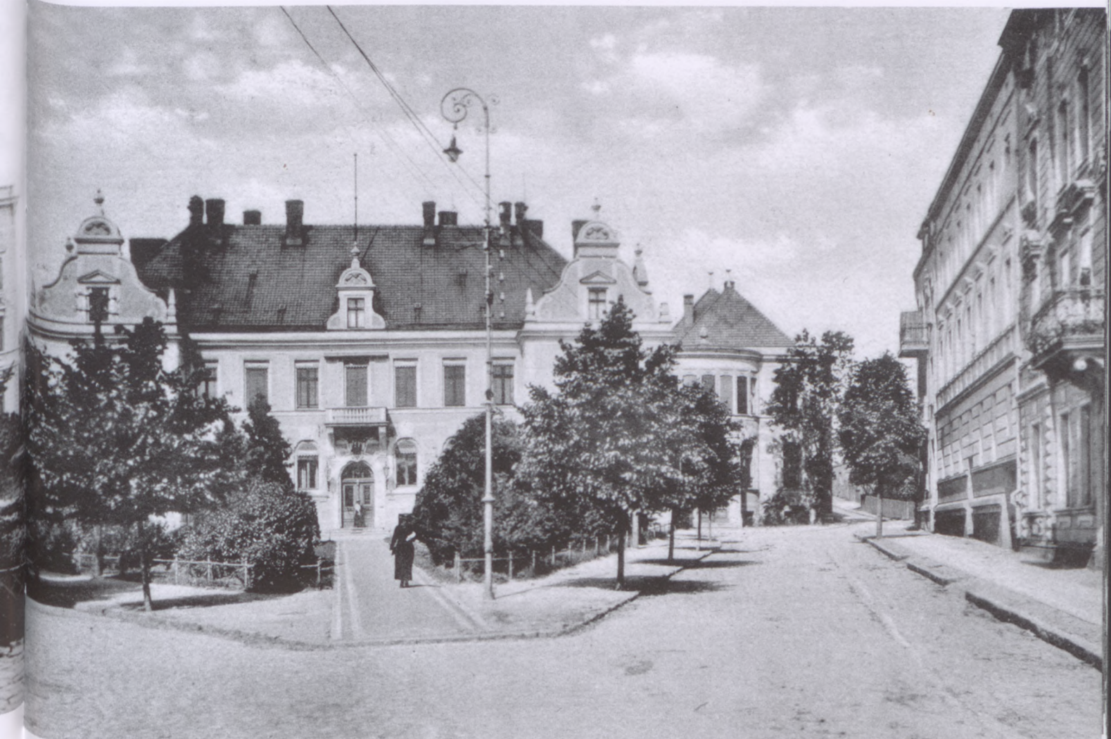
Budynek Starostwa Powiatowego. Druga dekada XX wieku. Widać początek obecnej ulicy Sienkiewicza.
