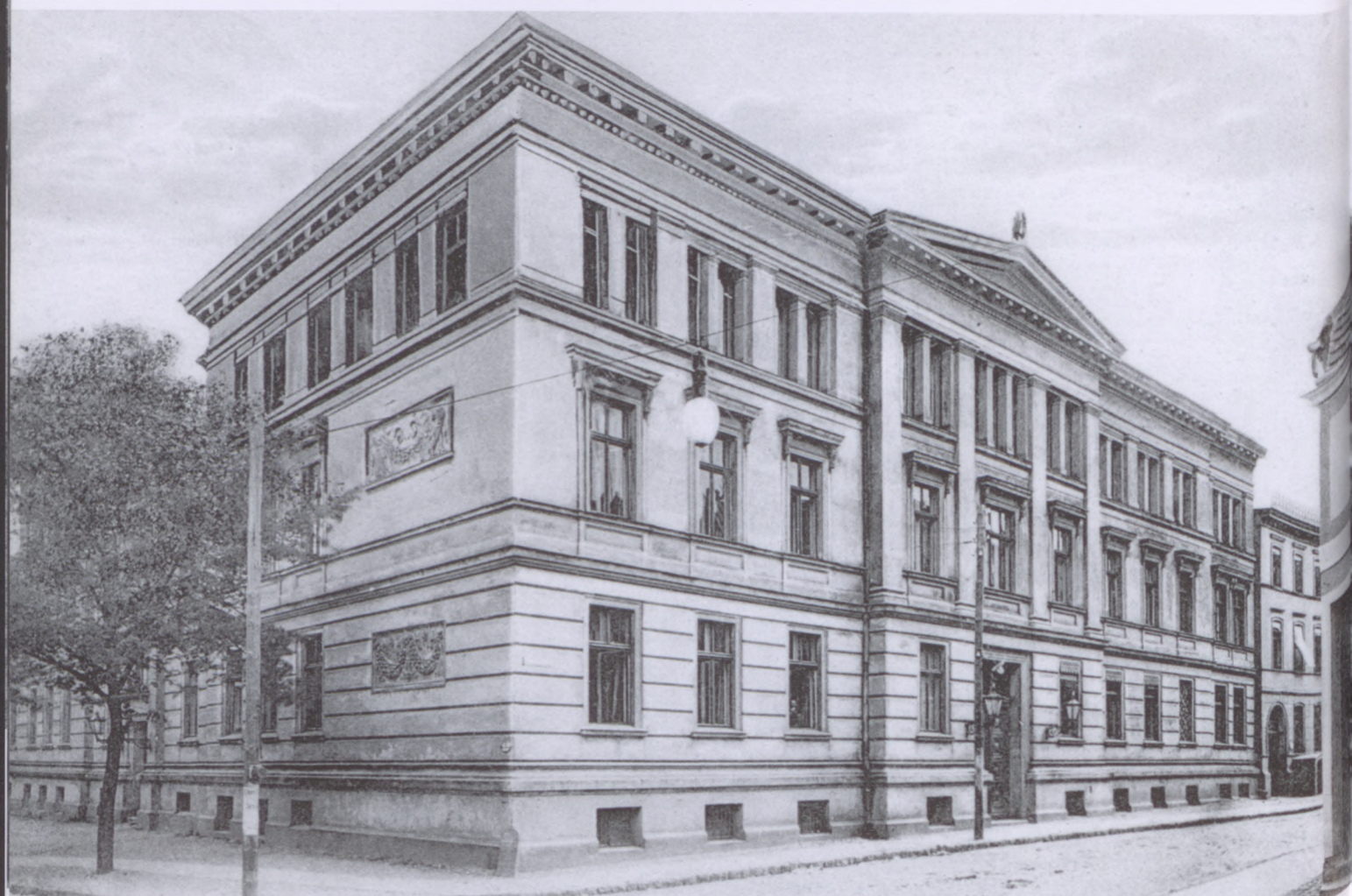
Elewacja frontowa. Pierwsze lata XX wieku. Nad ulicą lampa elektryczna, obok wejścia głównego latarnie gazowe.
