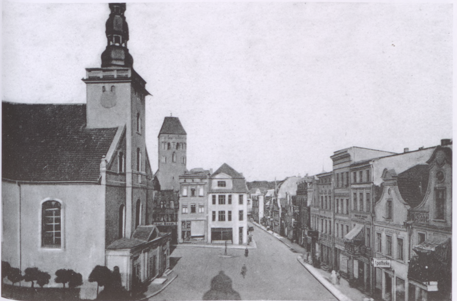
Narożna kamienica Rynek 18 / Gdańska w całkowicie nowej formie architektonicznej.
