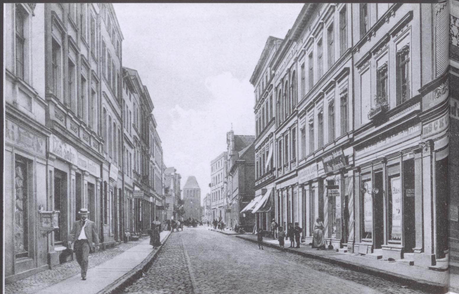
Ulica Gdańska (Danzigerstrasse) obecnie Kościuszki. Z prawej strony nieistniejące kamienice 11 - 19.
