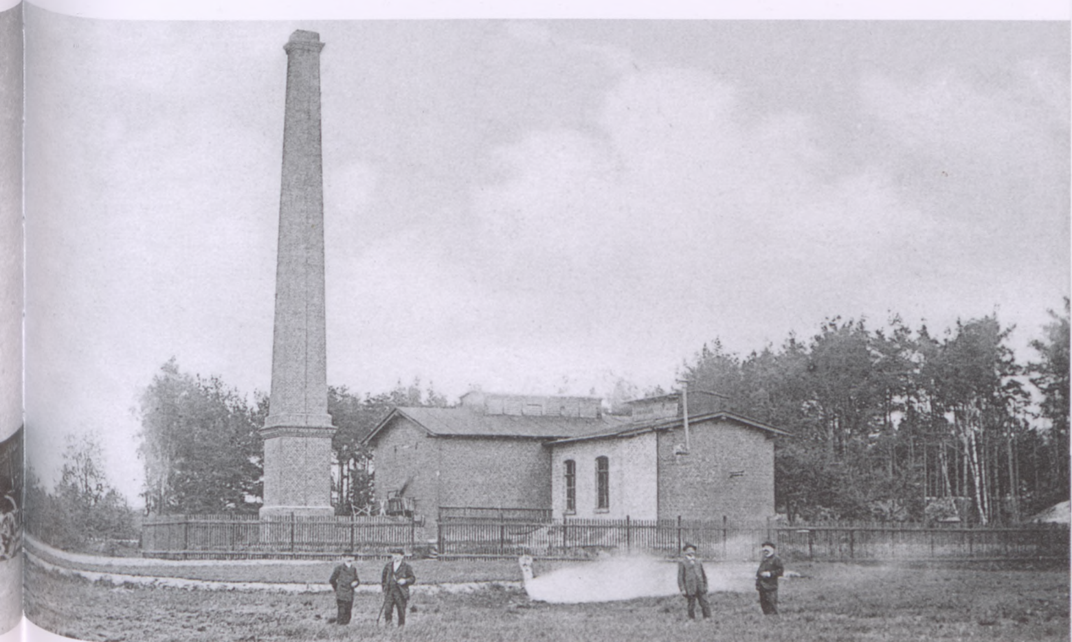
Stacja pomp w Krojantach zasilająca w wodę chojnicki dworzec.
