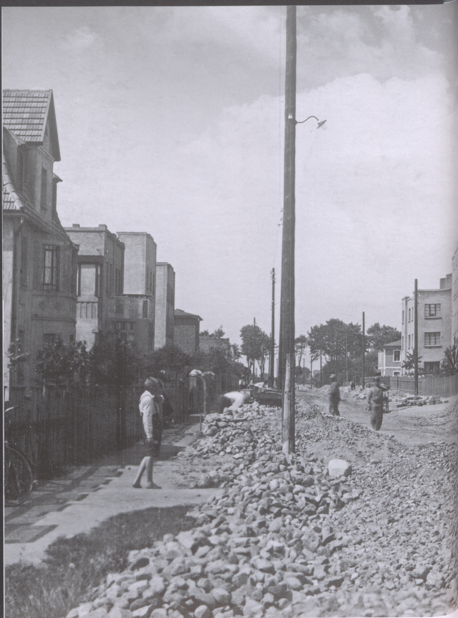
Budowa ulicy Gockowskiego.
