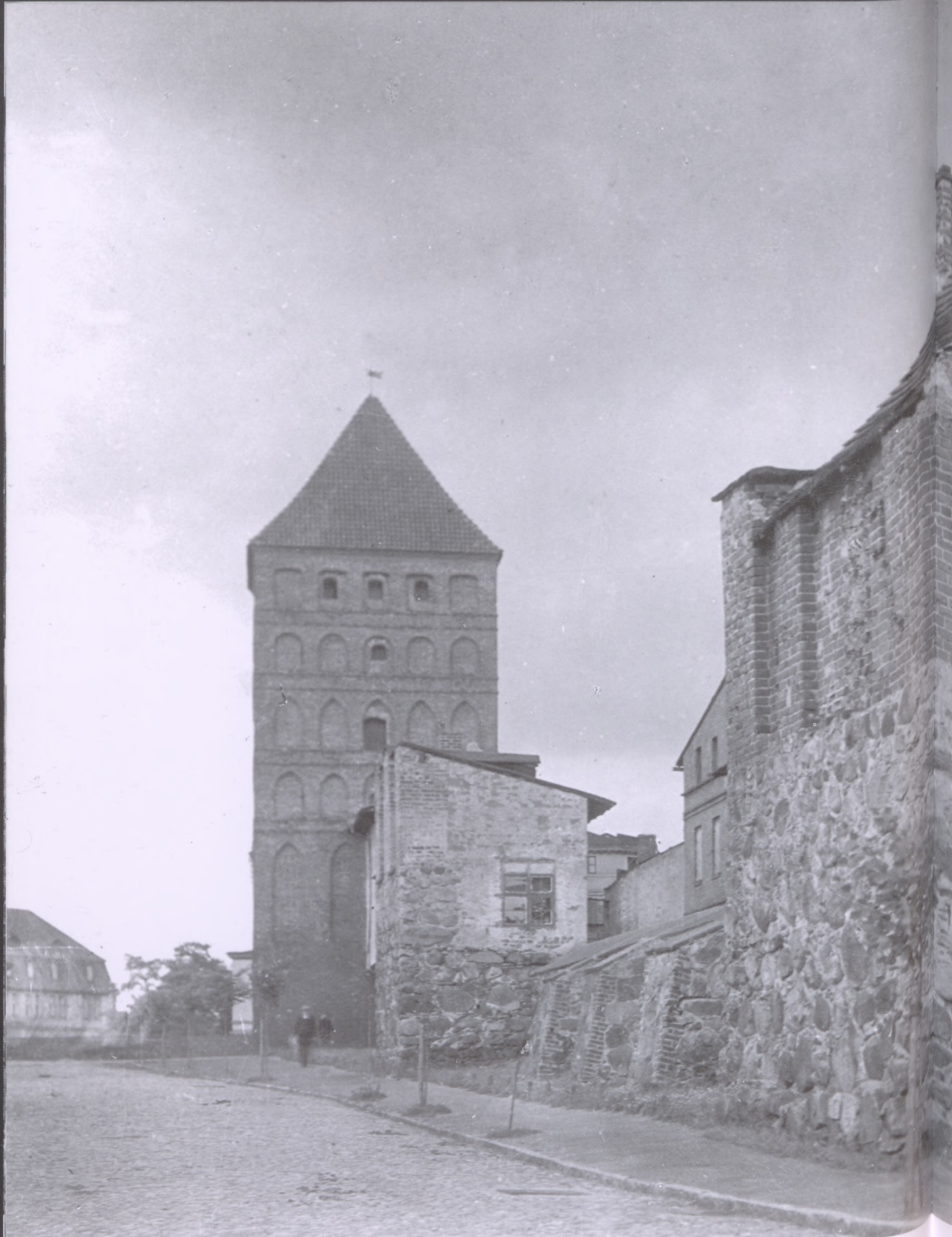
Pomiędzy Basztą Szewską a Domem Szewskim widoczne są trzy szkarpy muru miejskiego.
