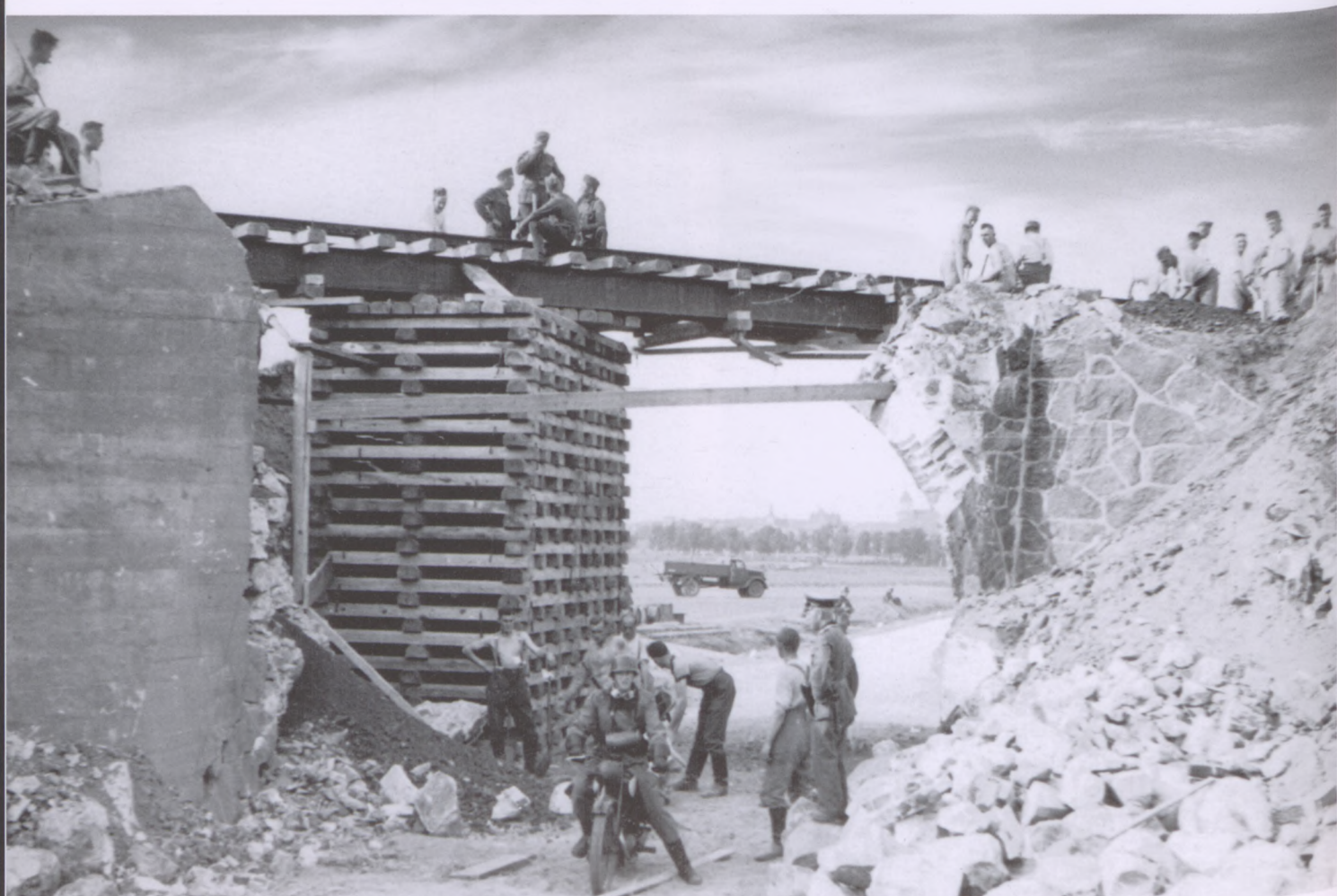
Bardzo szybko rozpoczęto naprawę wiaduktu – 8 września 1939 r.
