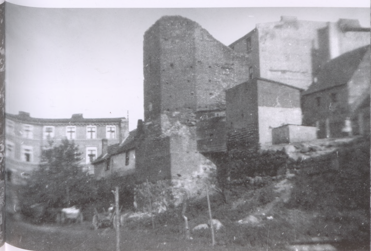
Na zdjęciu z roku 1937 widać stopniową destrukcję muru miejskiego.
