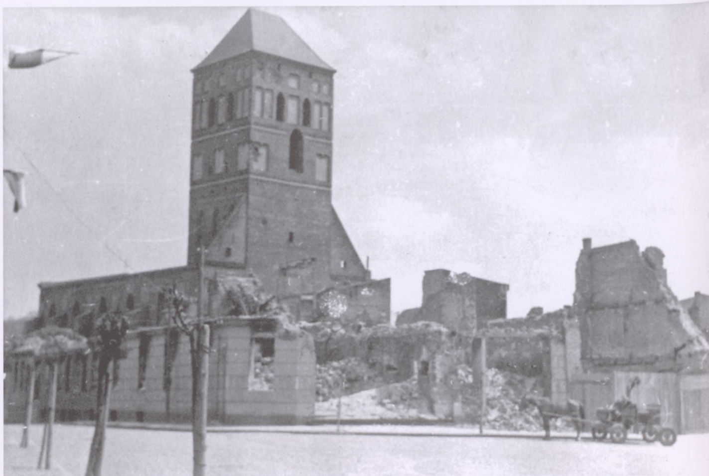
W pierwszej kolejności odbudowano dach nad wieżą.
