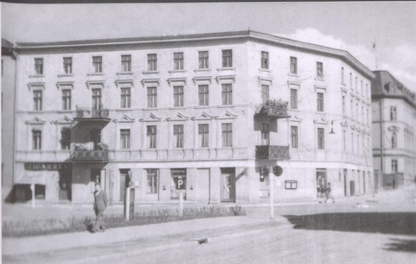
Kamienica przy ul. Gdańskiej 29 (obecnie Kościuszki 29).
