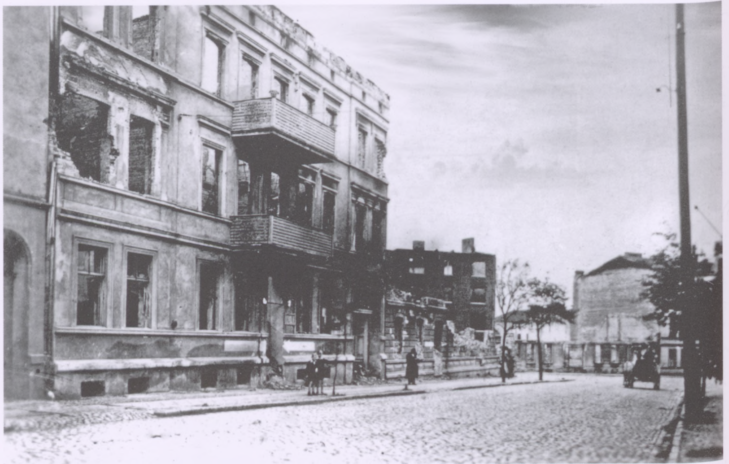
Zniszczone kamienice przy ul. Piłsudskiego 24 i 22.
