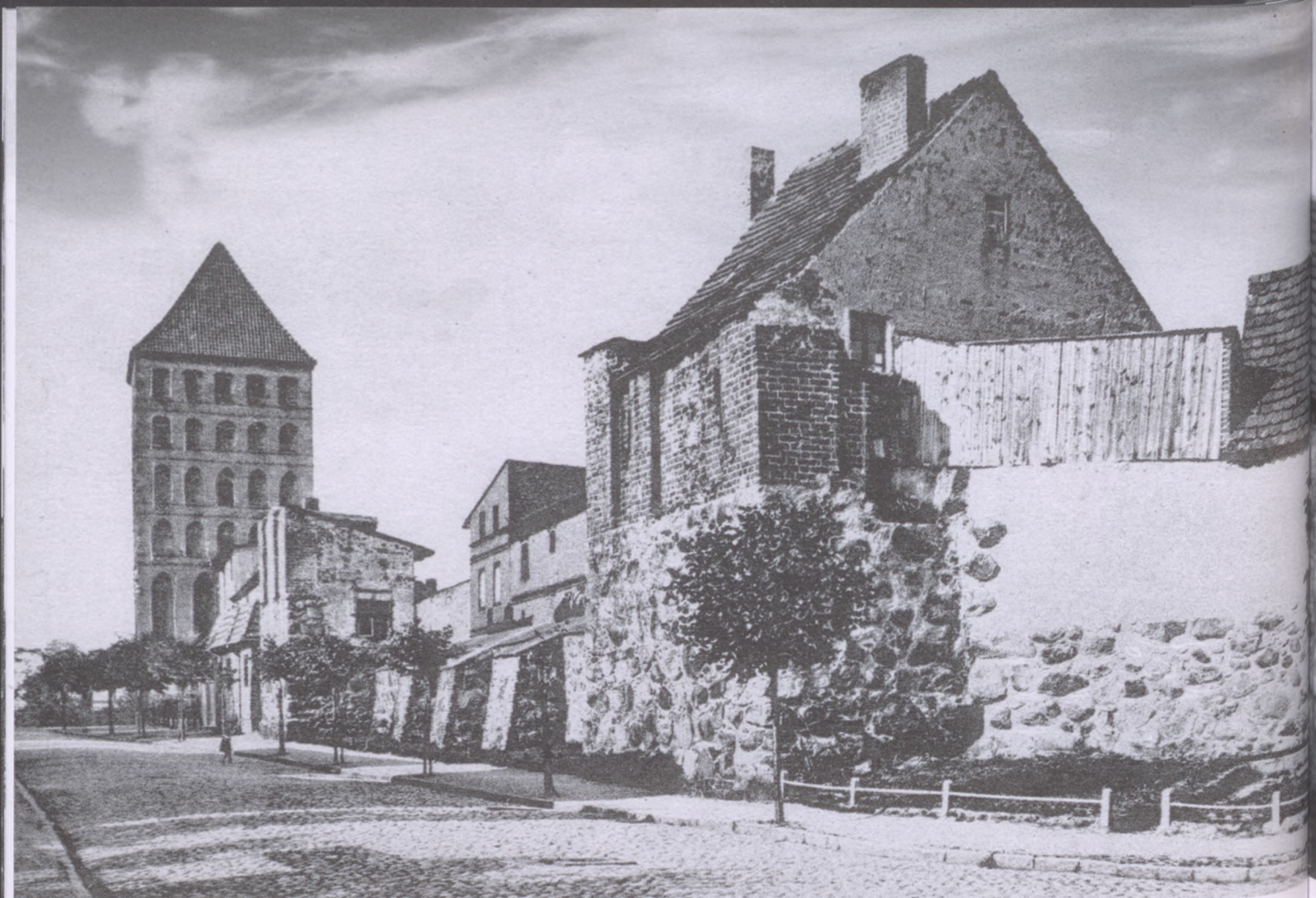
W latach 30. przeprowadzano niezbędne naprawy muru miejskiego.
