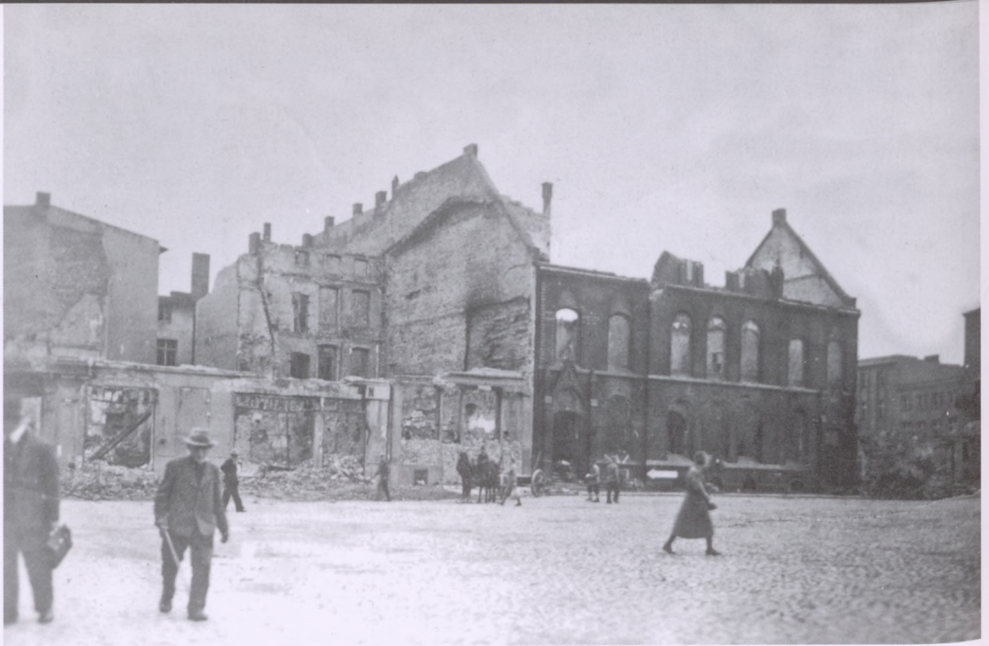
Zniszczona zachodnia „ściana” rynku.
