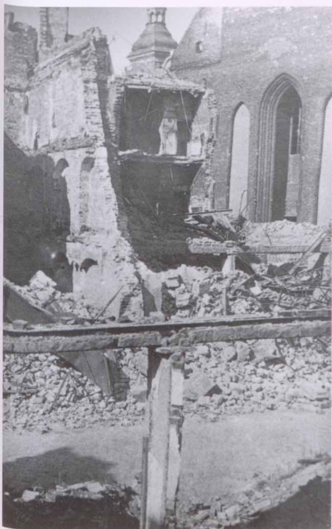
Ruiny kamienicy przy Gdańskiej 9.
