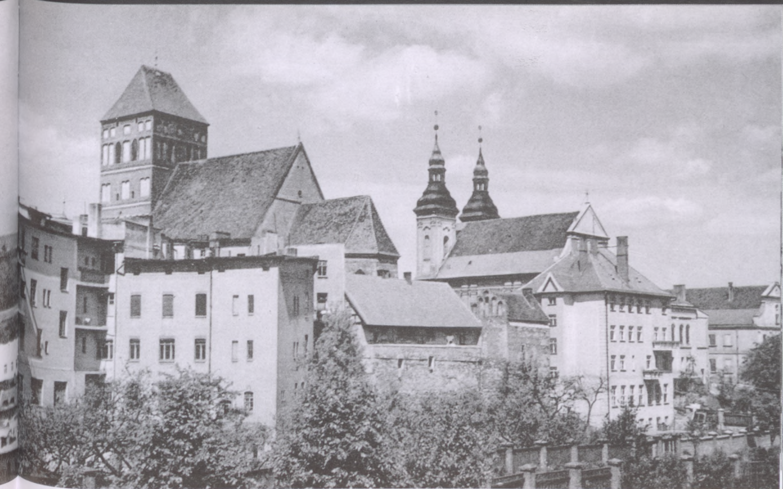
Widok centrum z Domu Mariańskiego. Poniżej fary widać oficynę kamienicy przy ul. Gdańskiej 23.
