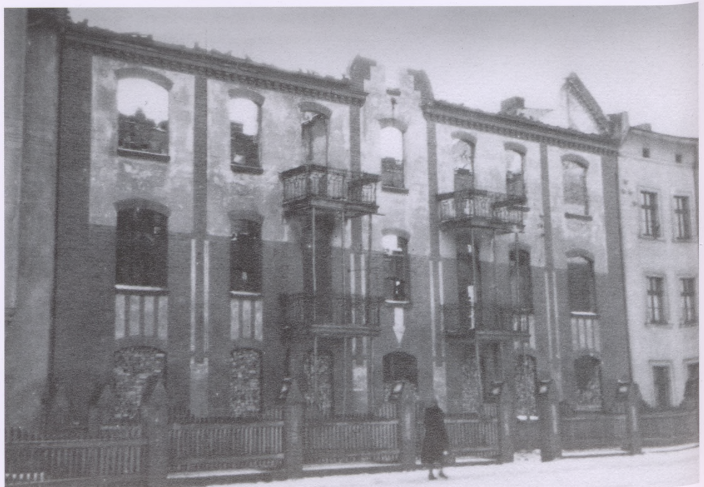
Spalona kamienica przy ul. Człuchowskiej 57 (obecnie 33).
