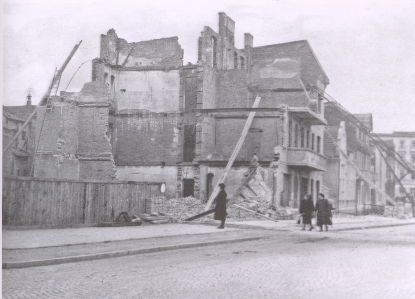
Kamienica w trakcie rozbiórki. Ulica wówczas nazywała się gen. Stalina.
