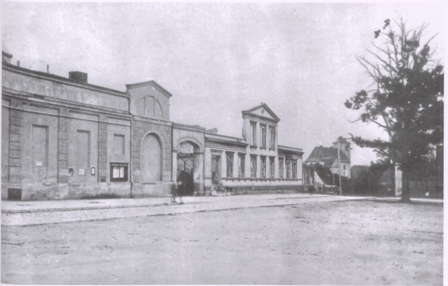
Zniszczona zabudowa placu Królowej Jadwigi (obecnie Niepodległości).
