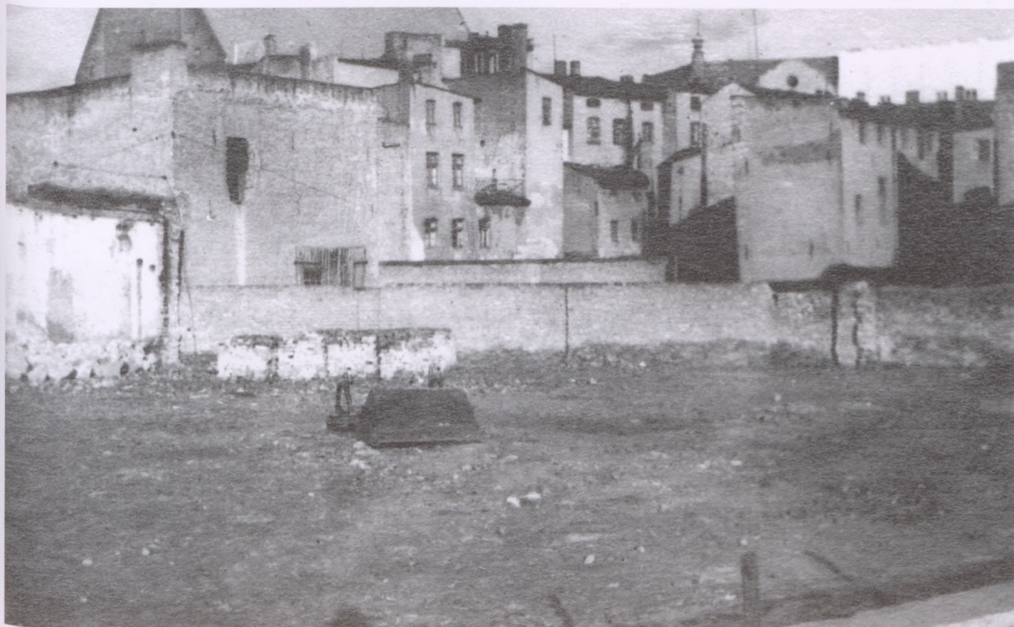
To samo miejsce po zakończeniu rozbiórki.
