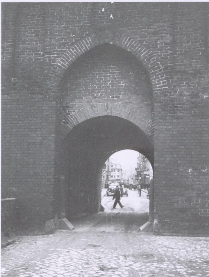
Portal zewnętrzny Bramy Człuchowskiej. Widać pokrywy systemu kanalizacji miejskiej.
