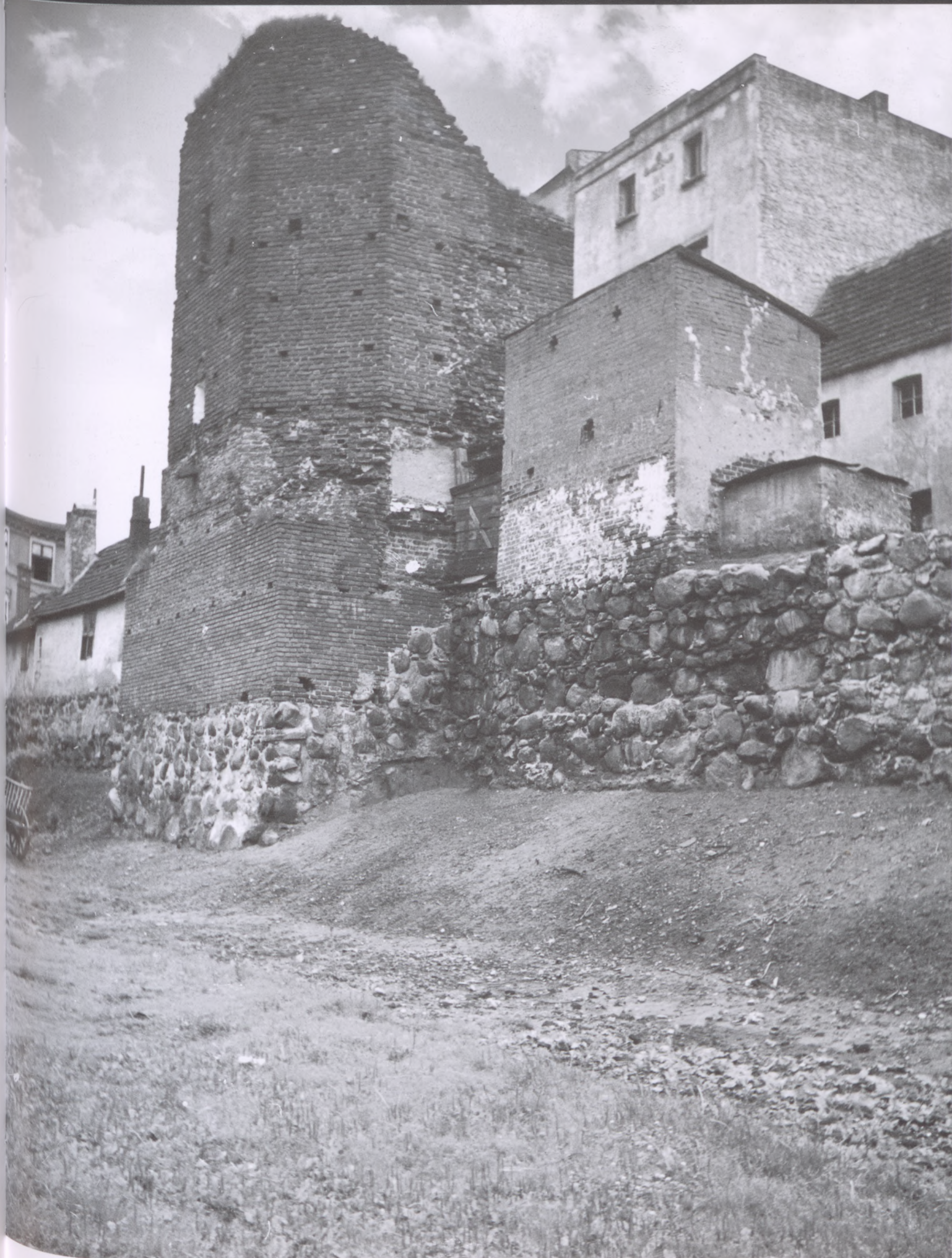
Na tym zdjęciu doskonale widać sposób budowy murów miejskich. Warstwy dużych głazów uzupełniane i wyrównywane były mniejszymi kamieniami.
