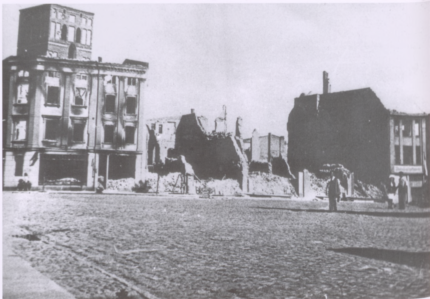
Zniszczona wschodnia „ściana” Starego Rynku.
