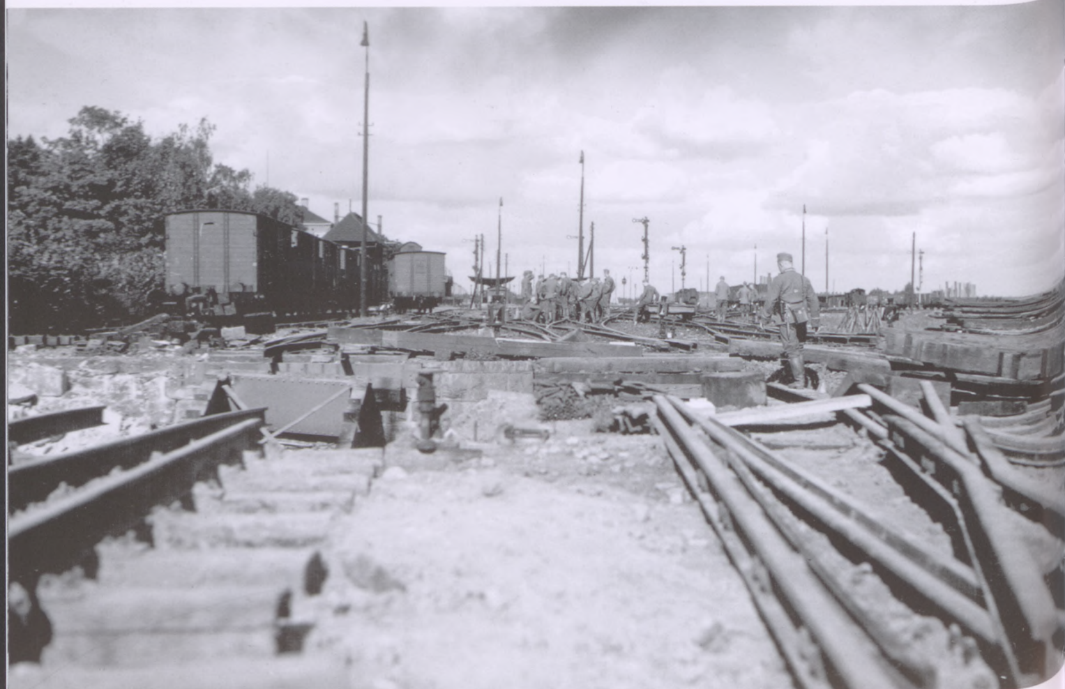
Fotografia wykonana ze zniszczonego wiaduktu w kierunku dworca.
