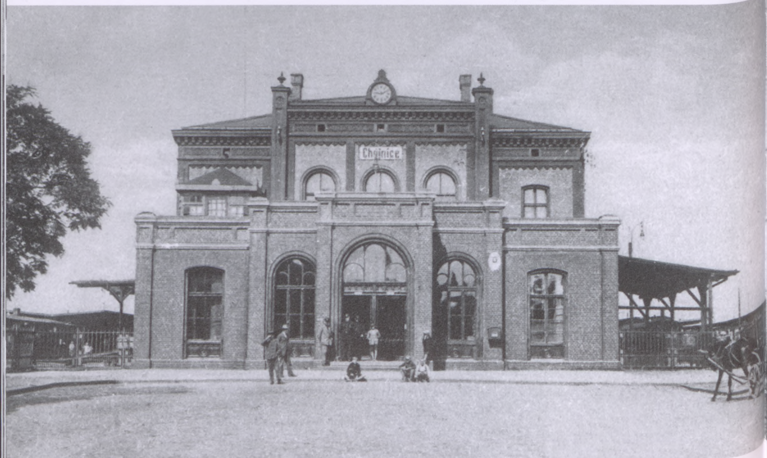
Ściana frontowa dworca z dobudowaną, jeszcze w czasach pruskich, częścią parterową mieszczącą kasy i hol.
