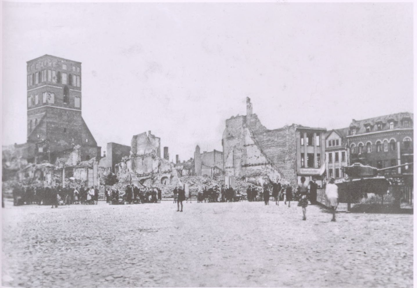
Fara straciła dach główny i dach wieży.
