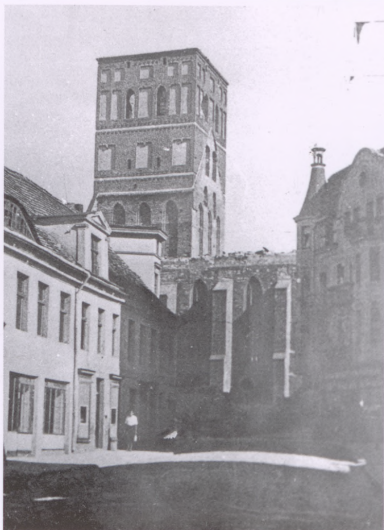
Zrujnowana fara. Widać szczegóły budowy wieży.
