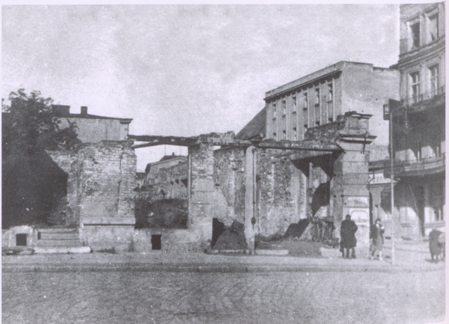
Zrujnowana narożna kamienica na Rynku 7.
