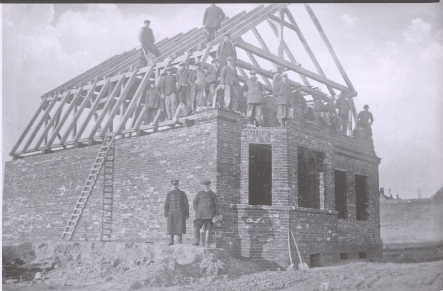
Budowa domu mieszkalnego. Róg alei Brzozowej i Sędzickiego. Kwiecień 1936 r.
