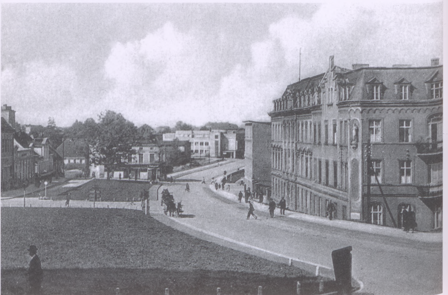
Ulica Rzeszy (Reichstrase) po zakończeniu przebudowy. Obecnie Gdańska.
