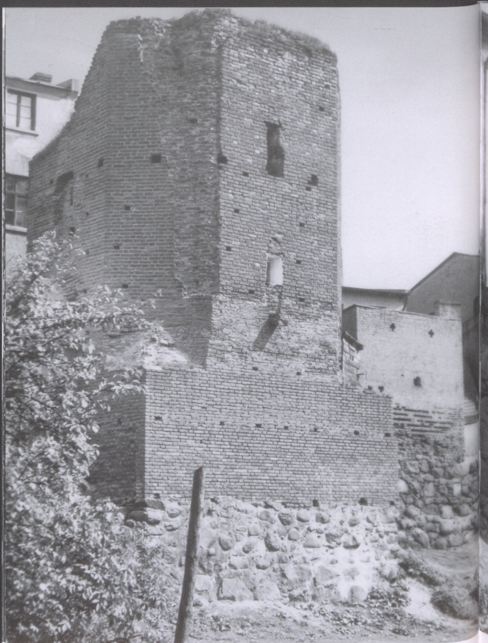
Baszta Wronia po wzmocnieniu przyziemia.
