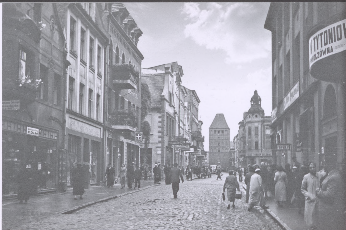
Widok na Bramę Człuchowską z ulicy Gdańskiej. 1938 rok.
