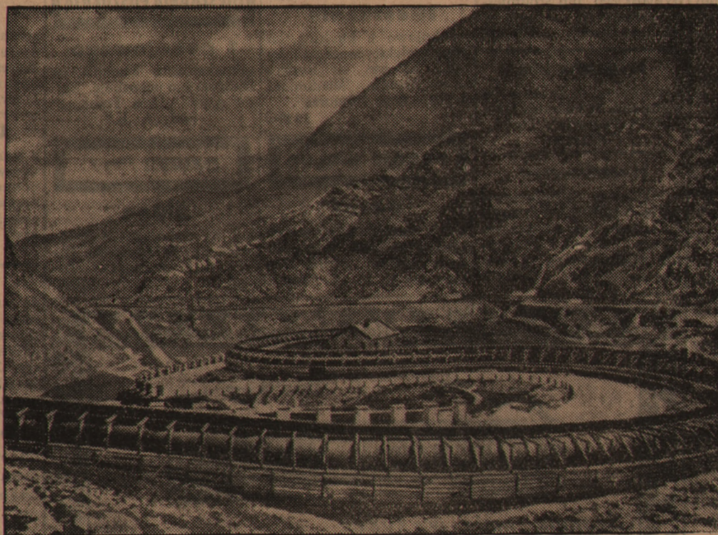
Ten olbrzymi tunel kolejowy u stop góry Mont Ceniz, między Francją a Italią został wybudowany w latach 1868—71. Wybudowano go tak mocno, że służy do dnia dzisiejszego, ale już nie jako tunel a ochrona toru.
