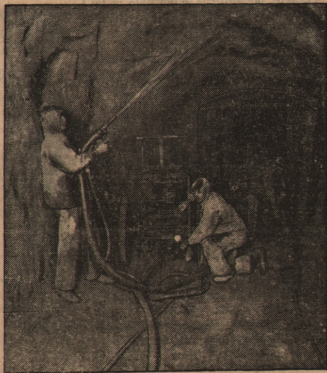
Celem zabezpieczenia chodników od zawalenia się, cementuje się je czyli gunituje. W tym celu przy pomocy specjalnych pomp pokrywa się ściany pod ciśnieniem powietrza roztworem wodnym cementu.
