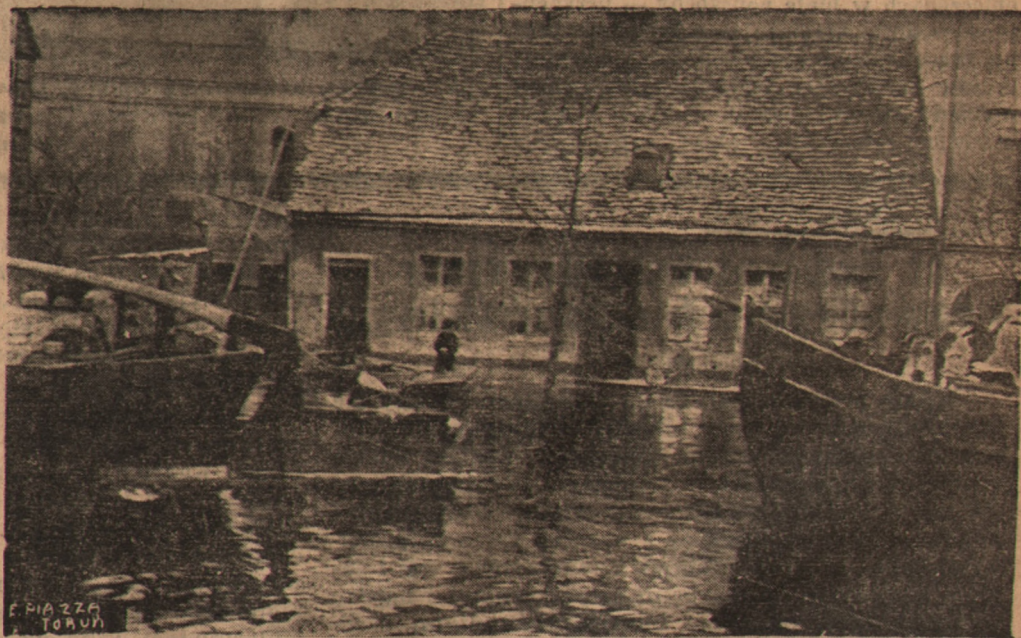
Stary domek przy ul. Hermana Frankego w Bydgoszczy pod wodą. Dojazd do tegoż domu odbywa się łódkami
