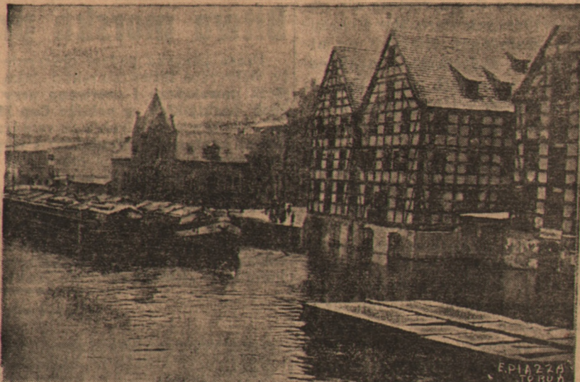
Piwnice zakładów przemysłowych L. Urbanowskiego w Bydgoszczy przy Rybim Rynku pod wodą
