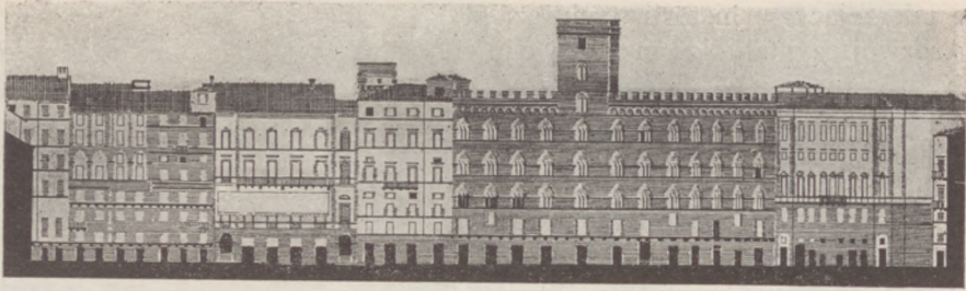
Rys. 145. Siena. Północna ściana placu del Campo.
