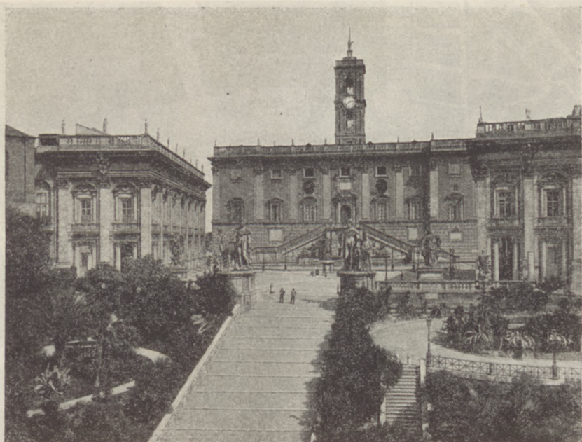
Rys. 226. R z y m. Kapitol. Widok rampy wejściowej i całości placu.
