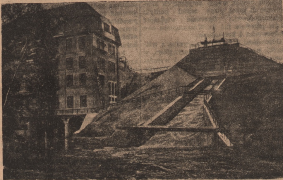
Już istniejący wielki zakład wodno-elektryczny w Gródku na Pomorzu
