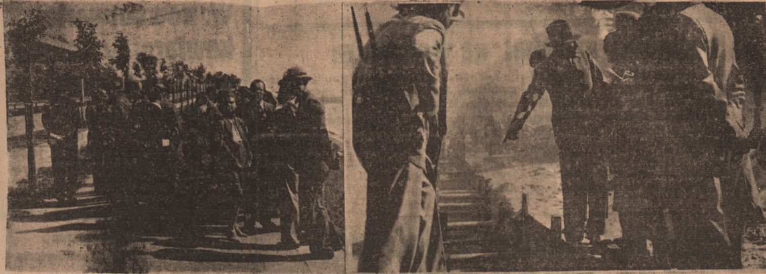
1) Grupa dziennikarzy warszawskich w Toruniu na ul. Traugutta, zwiedza roboty, wykonywane przy umacnianiu stoków nadwodociągowej w Toruniu na przestrzeni 5-ciu km od portu drzewnego do miasta. 2) Budowa magistratu (Dokończenie).
