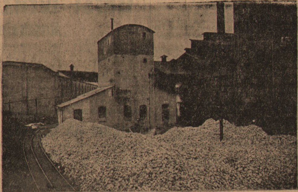
Piec wypalający wapno niezbędne do produkcji cukru.
