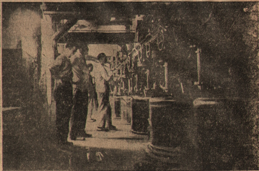
Blotniarki w których sok z wapnem przechodzi pierwszy proces oczyszczania, obok wysokosprawne wirówki. Tu kończy się ostatni etap produkcji cukru.
