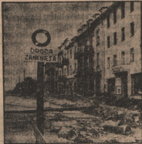
Roboty drogowe na ul. Kościuszki.
