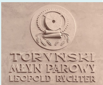
W efekcie remontu udało się odstąpić napis oraz odtworzyć jego fragment uszkodzony w trakcie prac
