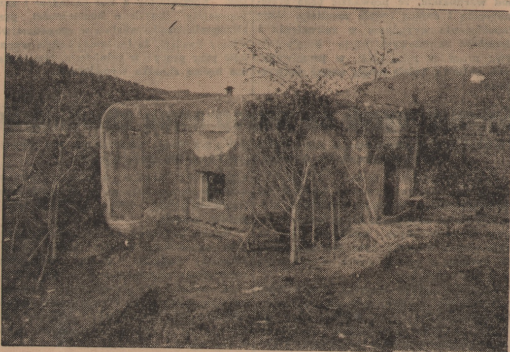
Betonowy schron czeski, jeden z wielu, jakie Czesi zbudowali wzdłuż granicy polskiej
