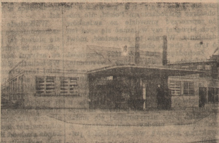
Fragment z obiektów dworca autobusowego i stacji obsługi „Polski Fiat”.
