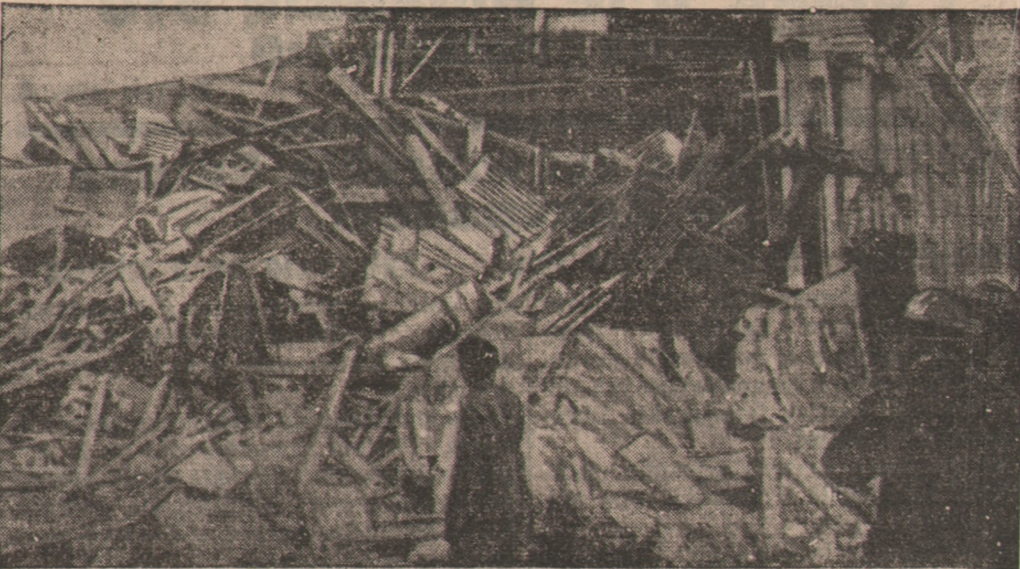
400 osób zgir pod gruzami tego zniszczonego przez trzęsienie ziemi teatru w Concepcion.
