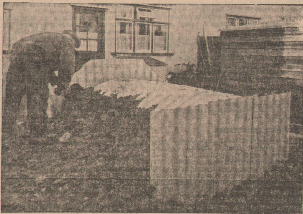
Rząd angielski przystąpił do produkcji małych, składanych schronów przeciwgazowych. Oto jeden ze zmontowanych schronów w ogródku podczas przykrywania ziemią
