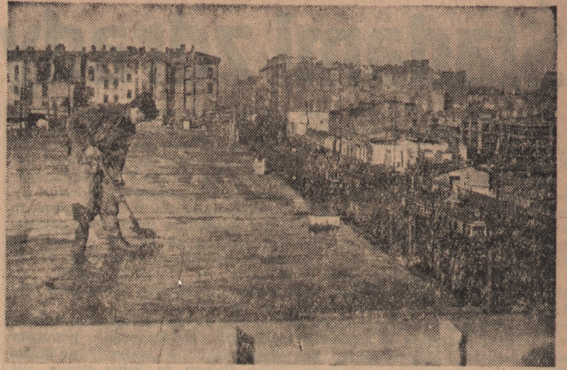
Betonowanie stropu II piętra na rogu Marszałkowskiej i Śniadeckich Foto — Film Polski
